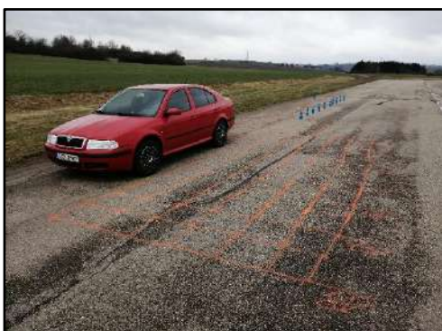
Obr. 63 Pohled na dráhu příčné přemístění [vlastní]
