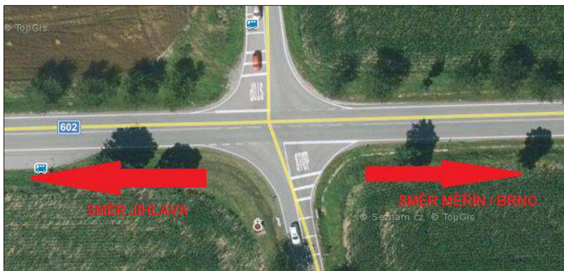
Obr. 39 Křižovatka na silnici č. 602 [65]
