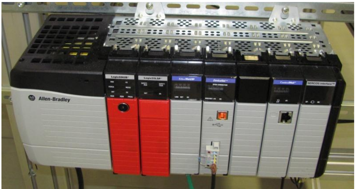
Obrázek 1: PLC manipulátoru
