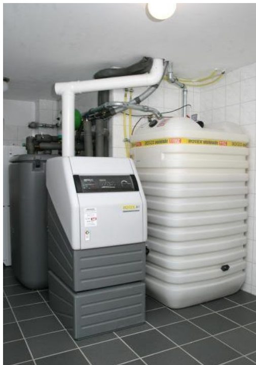
Obrázek 4.2 Kotel na topný olej s nádrží [24]
