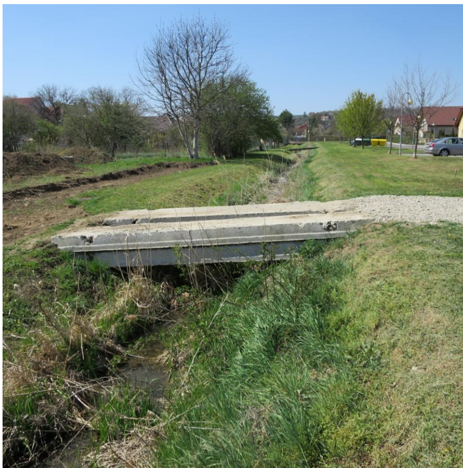
Obr. 14. Hospodářský sjezd omezující odtokové poměry bezejmenného toku (Podolí)
