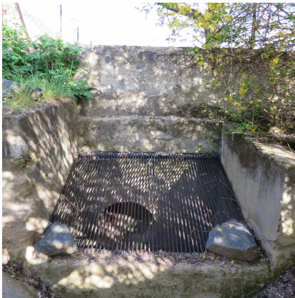
Obr. 26. Vtokový objekt s česlemi a odtokem do kanalizace potrubím DN 600
