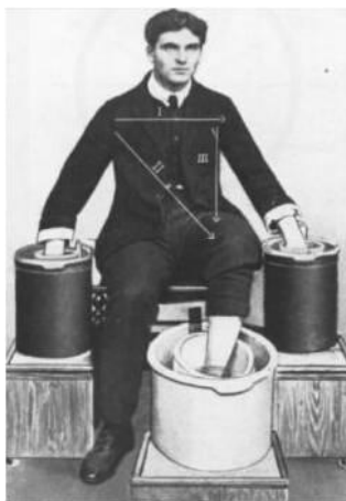
Obr. 2.2 Snímání EKG signálu přes sodný elektrolyt
