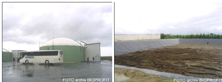
Obr. 32 Bioplynová stanice [37]. Obr. 33 Uskladnění neseparovaného fermentačního zbytku [37].
