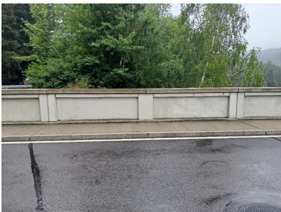
Obr. 15 Segment zábradlí hráze vodní nádrže
