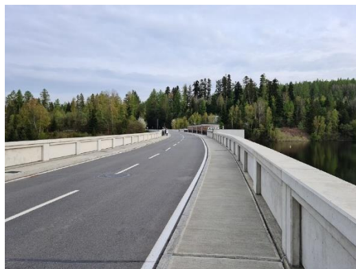
Obr. 14 Hráz vodní nádrže Kružberk po rekonstrukci
