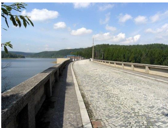
Obr. 13 Hráz přehrady Kružberk před rekonstrukcí
