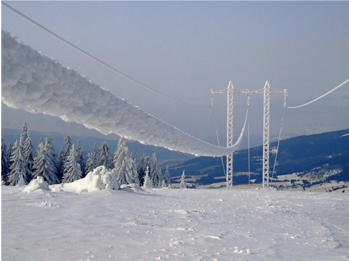
Obr. 21 - Zväzkový vodič pokrytý hrubou vrstvou námrazy
