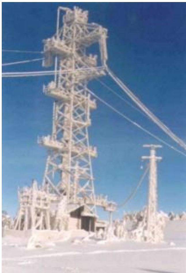
Obr. 20 - Stredný stožiar meracieho vedenia na stanici v Studniciach (podľa [9]).
