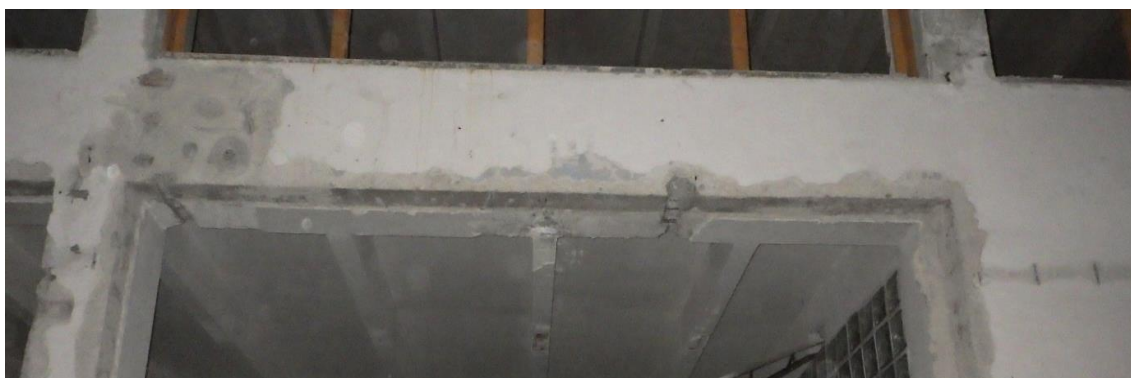
Obr. 126 Pohled na stropní průvlak nad 1. NP s provedenými sondami s označením P1.1 za účelem ověření vyztužení na ohybový moment uprostřed rozpětí a smykové účinky u vybrané podpory
