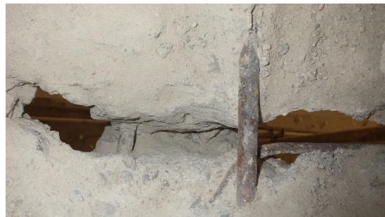
Obr. 178 Detailní foto sekané sondy v rámci sondy T2.1 za účelem ověření ohybové výztuže nad podporou
