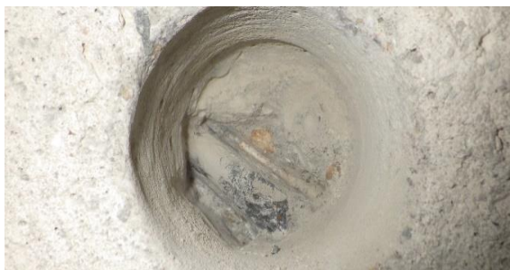
Obr. 129 Navrtaná sonda k určení radarové poloze jednoho ze dvou nalezených ohybů v rámci sondy P1.1
