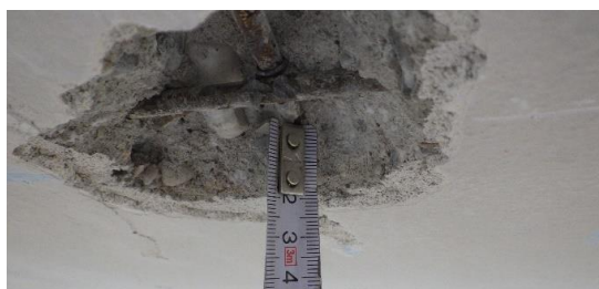
Obr. 234 Měření krycích vrstev hlavní nosné výztuže desky v rámci sondy D3.1
