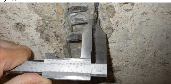
Obr. 192 Měření průměru třmínku průvlaku v rámci P2.2 posuvným měřítkem
