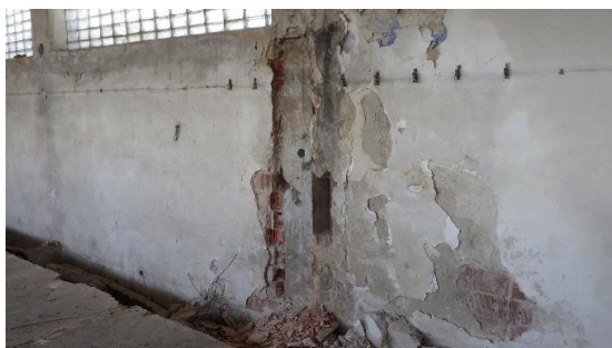
Obr. 211 Pohled na sloup ve 3. NP s provedenými sondami za účelem určení skutečného vyztužení (sonda S3.1)
