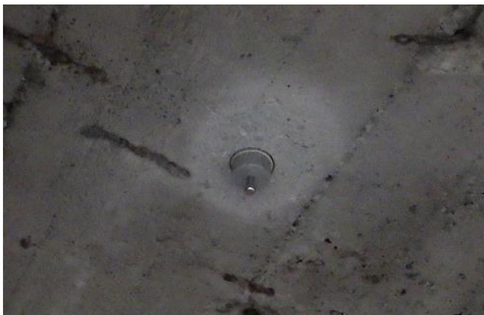
Obr. 8 Zkušební místo připravené k odtržení zkušební terče
