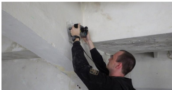
Obr. 60 Provádění odtrhové zkoušky na zkušebním místě umístěném na obloukovém průvlak
