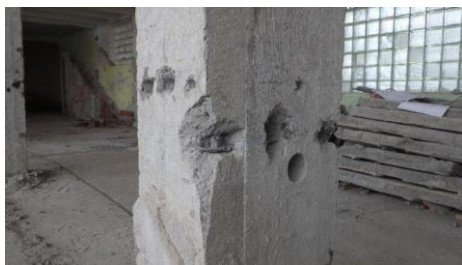
Obr. 87 Detailní pohled na provedenou oblast sekaných sond v místě sondy S1.1.
