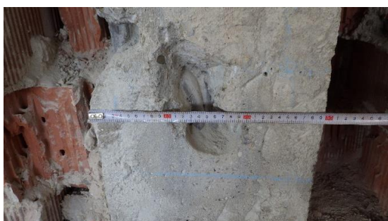
Obr. 213 Detailní pohled na provedenou oblast sekaných sond v rámci sondy S3.1 za účelem ověření skutečného vyztužení sloupu s rozměřením rozteční jednotlivých výztuží (čelní stěna z interiéru), viditelné dvě střední výztuže
