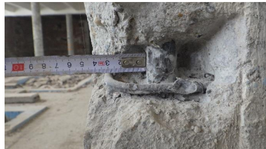
Obr. 92 Detailní foto měření krycích vrstev betonu vybrané rohové hlavní nosné výztuže sloupu v rámci provedené sondy S1.1
