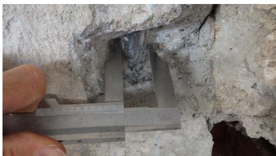
Obr. 215 Měření průměru hlavní nosné svislé výztuže sloupu v rámci sondy S3.1 posuvným měřítkem
