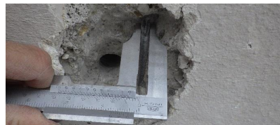
Obr. 183 Měření průměru hlavní nosné výztuže desky v rámci sondy D2.1 posuvným měřítkem
