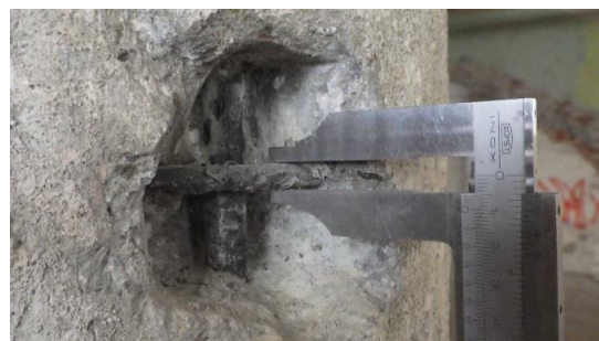
Obr. 108 Měření průměru třmínek sloupu v rámci sondy S1.3 posuvným měřítkem
