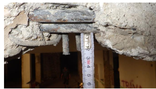
Obr. 137 Měření krycích vrstev betonu hlavní nosné výztuže žebra v rámci sondy T1.1
