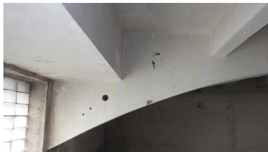
Obr. 167 Pohled na provedenou profometrickou a radarovou kontrolu polohy smykové výztuže (třmínků) u podpory v rámci sondy P2.1
