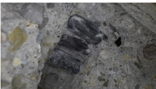
Obr. 196 Detailní foto výztužení v rámci sondy T2.2 uprostřed rozpětí s odhalenými výztužemi
