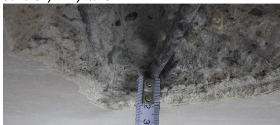
Obr. 182 Pohled na provedenou sekanou sondu D2.1 s měřením krycích vrstev betonu nosné výztuže desky
