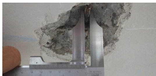
Obr. 235 Měření průměru hlavní nosné výztuže desky v rámci sondy D3.1
