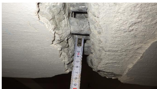
Obr. 170 Měření krycích vrstev betonu hlavní nosné výztuže průvlastku v rámci sondy P2.1
