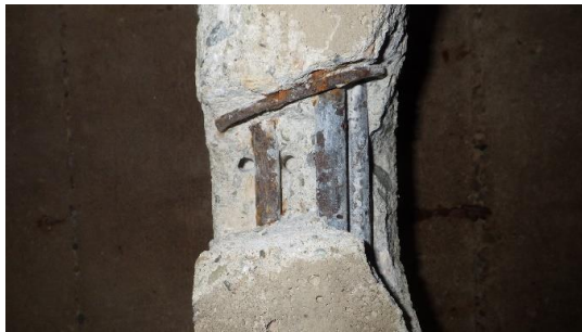
Obr. 146 Detailní foto vyztužení v rámci sondy T1.2 uprostřed rozpětí s odhalenými podélnými výztužemi a třmínkem
