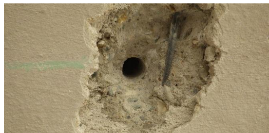
Obr. 181 Detailní pohled na provedenou sekanou sondu D1.3 včetně průvrtu k určení tloušťky desky
