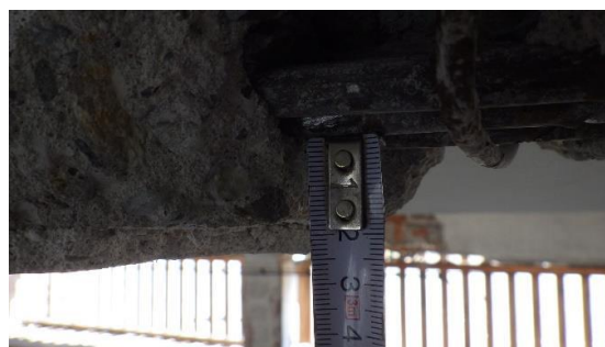
Obr. 228 Měření krycích vrstev betonu hlavní nosné výztuže žebra v rámci sondy T3.1
