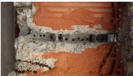
Obr. 239 Detailní foto vyztužení v rámci sondy P3.2 uprostřed rozpětí s odhalenými výztužemi
