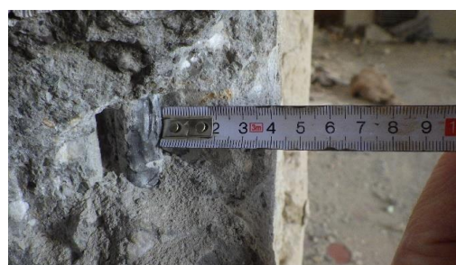
Obr. 115 Detailní foto měření krycích vrstev betonu vybrané hlavní nosné výztuže sloupu v rámci provedené sondy S1.4
