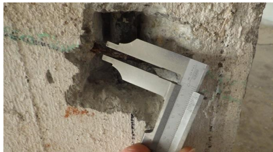
Obr. 164 Měření průměru třmínkové výztuže sloupu v rámci sondy S2.1 posuvným měřítkem
