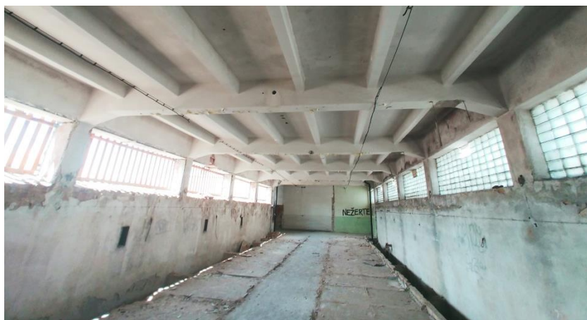
Obr. 18 Pohled na nosný systém 3.NP
