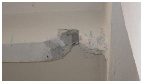
Obr. 135 Pohled na provedenou sekanou sondu v rámci T1.1 u vybrané podpory za účelem ověření počtu zatažených prutů do podpory
