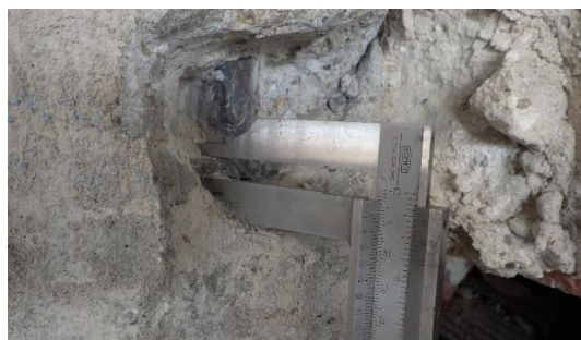
Obr. 216 Měření průměru třmínkové výztuže sloupu v rámci sondy S3.1 posuvným měřítkem
