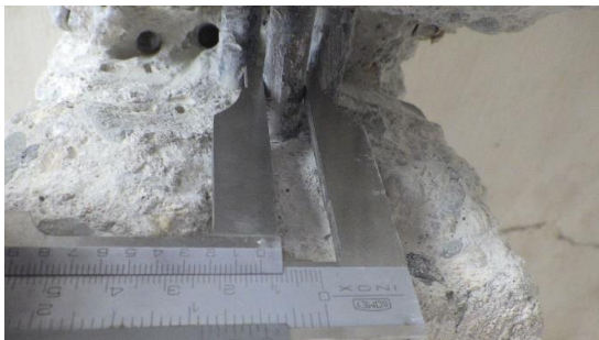
Obr. 177 Měření průměru hlavní nosné výztuže žebra v rámci sondy T2.1 posuvným měřítkem
