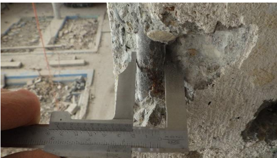
Obr. 163 Měření průměru hlavní nosné svislé výztuže sloupu v rámci S2.1 posuvným měřítkem
