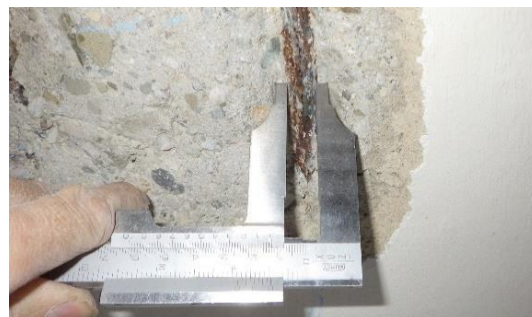
Obr. 155 Měření průměru hlavní nosné výztuže desky v rámci sondy D1.3 posuvným měřítkem
