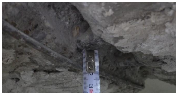
Obr. 130 Měření krycích vrstev betonu hlavní nosné výztuže průvlaku v rámci sondy P1.1
