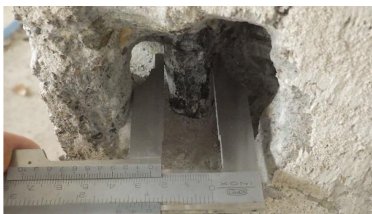
Obr. 100 Měření průměru hlavní nosné svíslé výztuže sloupu v rámci sondy S1.2 posuvným měřítkem
