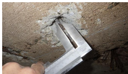
Obr. 152 Měření průměru hlavní nosné výztuže desky v rámci sondy D1.2 posuvným měřítkem
