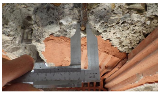
Obr. 242 Měření průměru třmínku střešního průvlaku v rámci sondy P3.2 posuvným měřítkem
