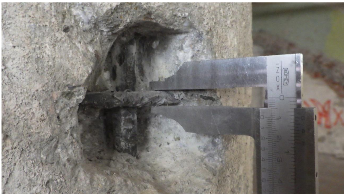
Obr. 15 Měření průměru třmínku v sekané sondě sloupu.
