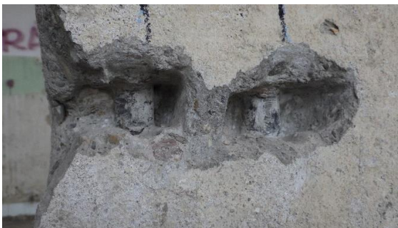
Obr. 98 Detailní pohled na dvě odhalené svíslé nosné výztuže sloupu v 1. NP v rámci sondy S1.2, výztuže bez povrchové koroze, bez známek mechanického poškození
