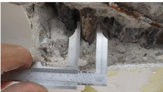
Obr. 222 Měření průměru hlavní nosné výztuže střešního průvlaku v rámci sondy P3.1 posuvným měřítkem
