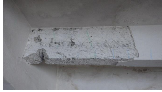
Obr. 174 Pohled na provedenou sekanou sondu v rámci T2.1 u vybrané podpory za účelem ověření počtu zatažených prutů do podpory
