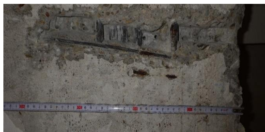
Obr. 188 Detailní foto sekané sondy v rámci P2.2 za účelem ověření ohybové výztuže nad podporou
