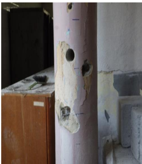
Obr. 119 Pohled na sloup v 1. NP s provedenými sondami za účelem určení skutečného vyztužení (sonda S1.5)
