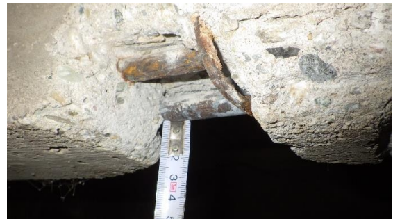
Obr. 147 Měření krycích vrstev betonu hlavní nosné výztuže žebra v rámci sondy T1.2
