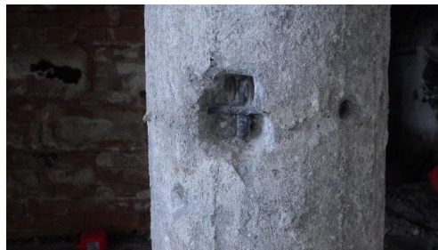
Obr. 104 Detailní pohled na provedenou oblast sekání sond za účelem ověření skutečného vyztužení sloupu.
