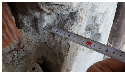
Obr. 214 Detailní foto měření krycích vrstev betonu vybrané rohové hlavní nosné výztuže sloupu v rámci provedené sondy S3.1
