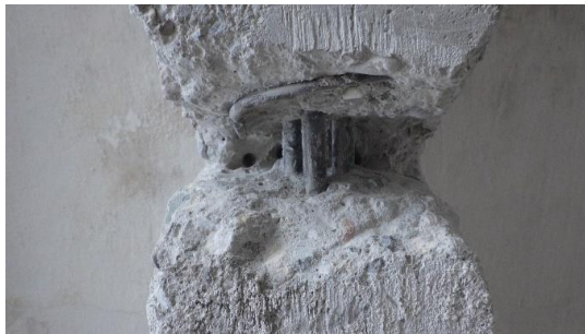
Obr. 175 Detailní foto vyztužení v rámci sondy T2.1 uprostřed rozpětí s odhalenými podélnými výztužemi a třmínkem
