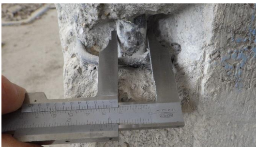
Obr. 93 Měření průměru hlavní nosné svislé výztuže sloupu v rámci sondy S1.1 posuvným měřítkem
