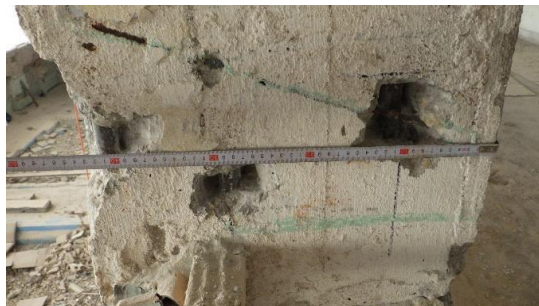
Obr. 161 Detailní pohled na provedenou oblast sekaných sond v rámci S2.1 za účelem ověření skutečného vyztužení sloupu s rozměření rozteční jednotlivých výztuží
