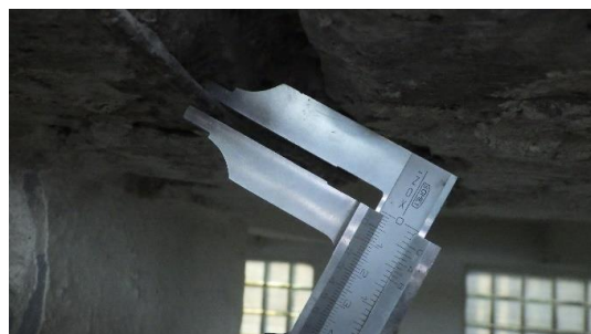
Obr. 132 Měření průměru třmínkové výztuže průvlaku v rámci sondy P1.1 posuvným měřítkem
