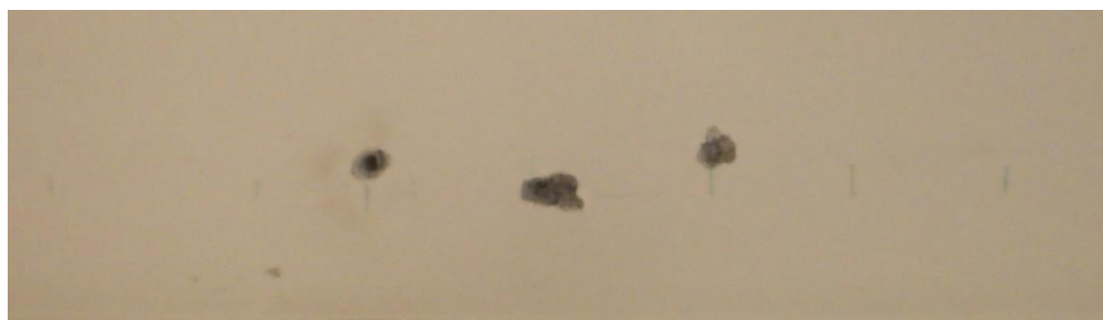
Obr. 142 Vyznačení polohy výztuží v místě sondy D1.1
