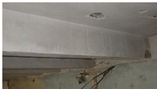
Obr. 195 Pohled na rozkreslené polohy třmínků na bočním líci žebra v rámci sondy T2.2
