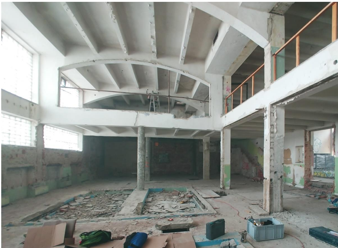
Obr. 17 Pohled na nosný systém 1.NP a 2.NP
