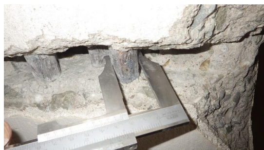
Obr. 171 Měření průměru nosné výztuže průvlastku v rámci sondy P2.1 posuvným měřítkem
