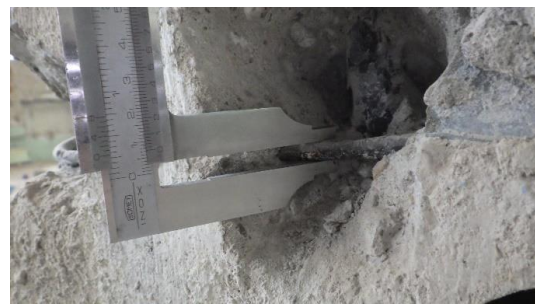
Obr. 94 Měření průměru třmínků sloupu v rámci sondy S1.1 posuvným měřítkem
