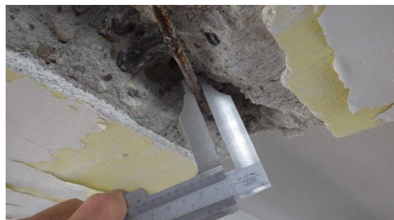
Obr. 223 Měření průměru třmínku střešního průvlaku v rámci sondy P3.1 posuvným měřítkem
