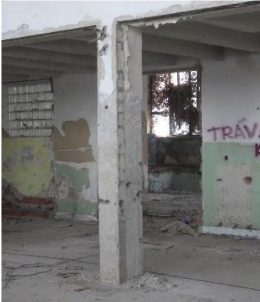
Obr. 96 Pohled na sloup v 1. NP s provedenými sondami za účelem určení skutečného vyztužení (sonda S1.2)
