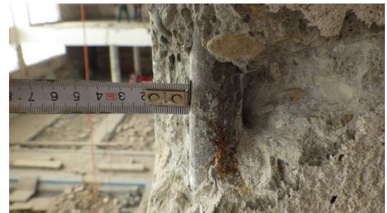
Obr. 162 Detailní foto měření krycích vrstev betonu vybrané rohové hlavní nosné výztuže sloupu v rámci provedené sondy S2.1
