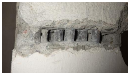
Obr. 82 Sekaná sonda průvlaku
