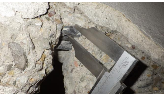
Obr. 198 Měření průměru hlavní nosné výztuže žebra v rámci sondy T2.2 posuvným měřítkem
