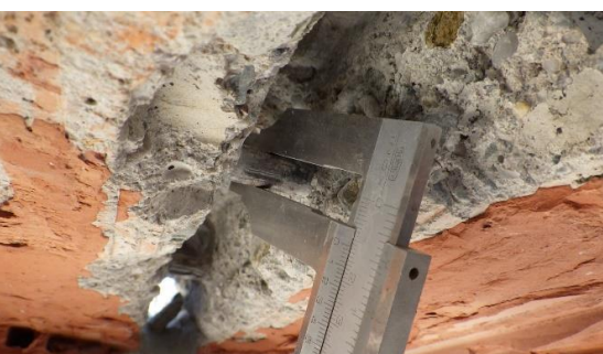
Obr. 241 Měření průměru hlavní nosné výztuže střešního průvlaku v rámci sondy P3.2 posuvným měřítkem
