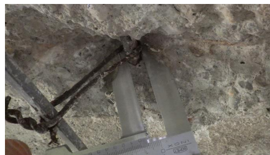
Obr. 247 Měření průměru hlavní nosné výztuže v rámci sondy D3.2
