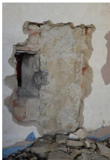
Obr. 111 Pohled na sloup v 1. NP s provedenými sondami za účelem určení skutečného vyztužení (sonda S1.4) v exteriéru
