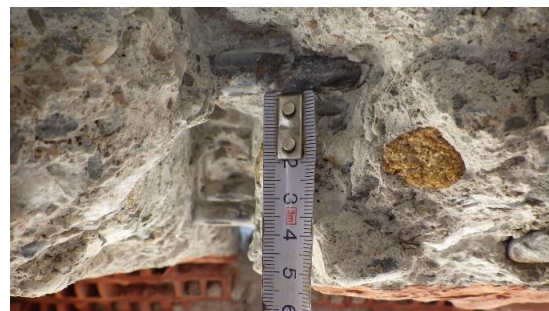
Obr. 240 Měření krycích vrstev betonu hlavní nosné výztuže střešního průvlaku v místě sondy P3.2
