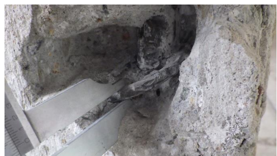
Obr. 101 Měření průměru třmínků sloupu v rámci sondy S1.2 posuvným měřítkem
