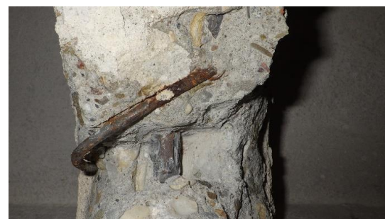
Obr. 197 Detailní foto sekané sondy v rámci sondy T2.2 za účelem ověření výztuže u podpory
