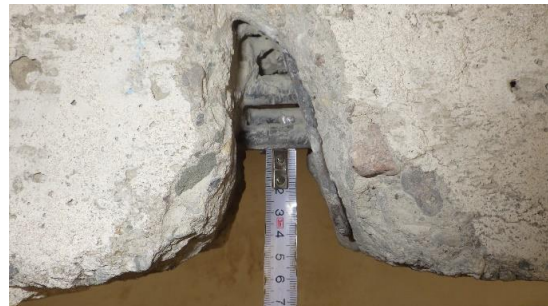
Obr. 176 Měření krycích vrstev betonu hlavní nosné výztuže žebra v rámci sondy T2.1
