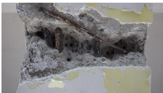
Obr. 220 Detailní foto výztužení v rámci sondy P3.1 uprostřed rozpětí s odhalenými výztužemi
