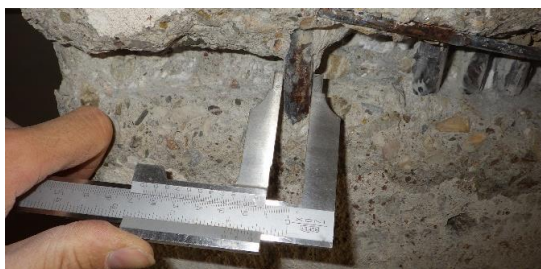
Obr. 191 Měření průměru hlavní nosné svislé výztuže průvlaku v rámci P2.2 posuvným měřítkem
