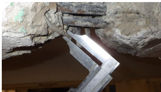
Obr. 139 Měření průměru třmínkové výztuže žebra v rámci sondy T1.1 posuvným měřítkem
