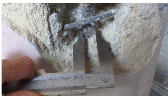
Obr. 123 Měření průměru hlavní nosné svislé výztuže sloupu v rámci sondy S1.5 posuvným měřítkem
