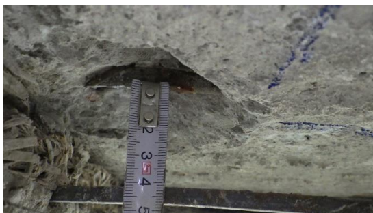
Obr. 246 Měření krycích vrstev betonu hlavní nosné výztuže v rámci sondy D3.2
