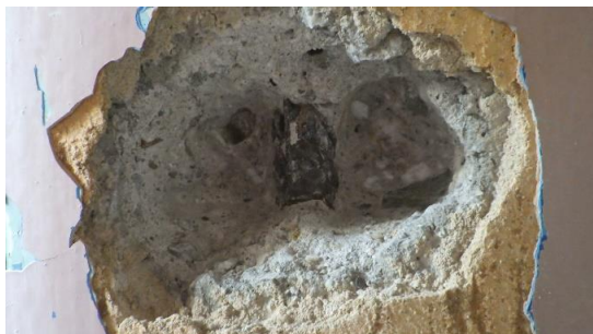
Obr. 121 Detailní pohled na odhalenou svislou výztuž sloupu v 1. NP v rámci sondy S1.5, výztuže bez povrchové koroze, bez známek mechanického poškození
