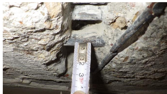
Obr. 189 Měření krycích vrstev betonu hlavní nosné výztuže průvlaku v rámci P2.2
