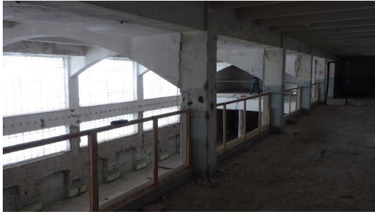
Obr. 159 Pohled na sloup ve 2. NP s provedenými sondami za účelem určení skutečného vyztužení (sonda S2.1)
