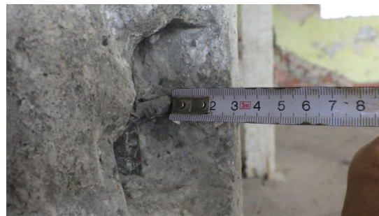
Obr. 106 Detailní foto měření krycích vrstev betonu vybrané hlavní nosné výztuže sloupu v rámci provedené sondy S1.3
