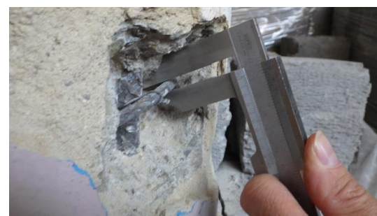
Obr. 124 Měření průměru třmíneků sloupu v rámci sondy S1.5 posuvným měřítkem
