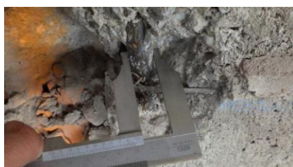
Obr. 116 Měření průměru hlavní nosné výztuže sloupu v rámci sondy S1.4 posuvným měřítkem
