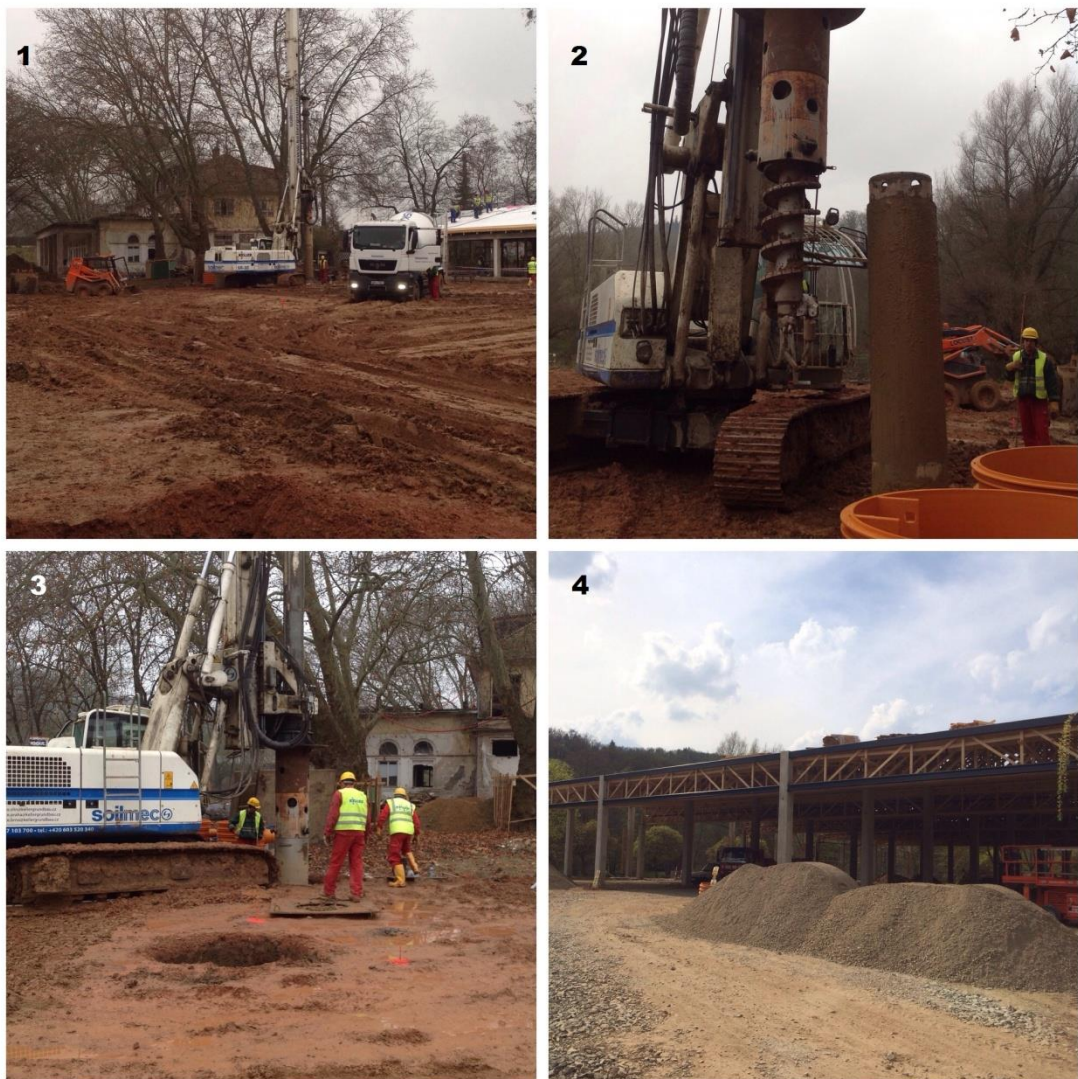
Obr. 5-32: 1) Prostor staveniště, 2) Vrtací souprava, 3) Vrtání piloty, 4) Skelet stavby [foto autor]
