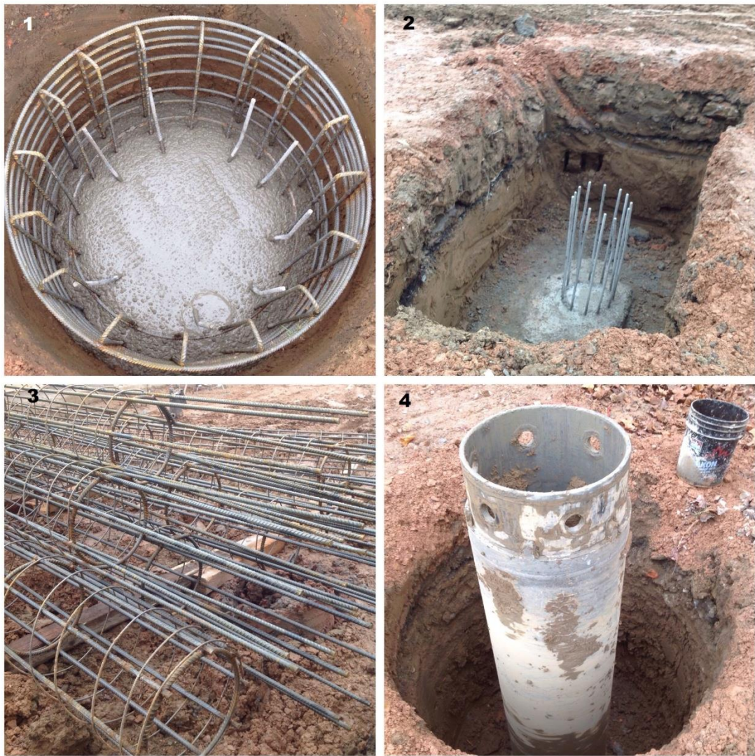
Obr. 5-31: 1) Kruhová pilota, 2) Kopaná hlavice, 3) Armokoše, 4) Ocelová pažnice [foto autor]
