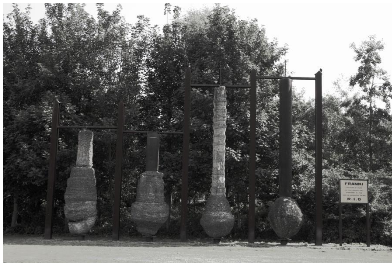
Obr. 4-17: Ukázka cibulovitého tvaru pat pilot[12]
