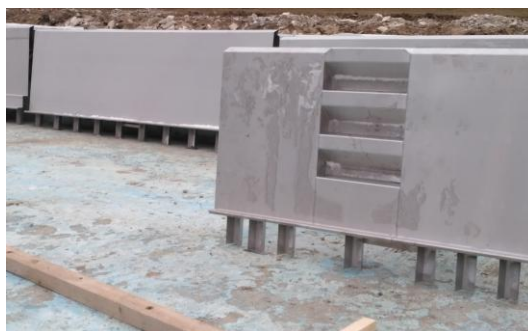
Obrázek 56: Stěny nerezové bazénové vany, CENTROPROJEKT GROUP a.s.
