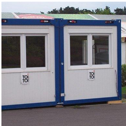
Obrázek 14: Staveništní buňka - napojení na elektrickou energii [14]
