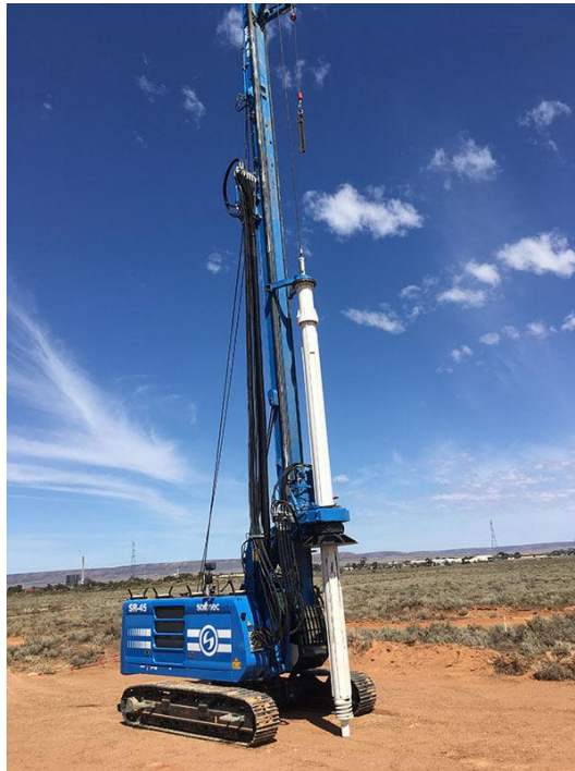
Obrázek 33: Vrtná souprava SOILMEC SR-45 [33]
