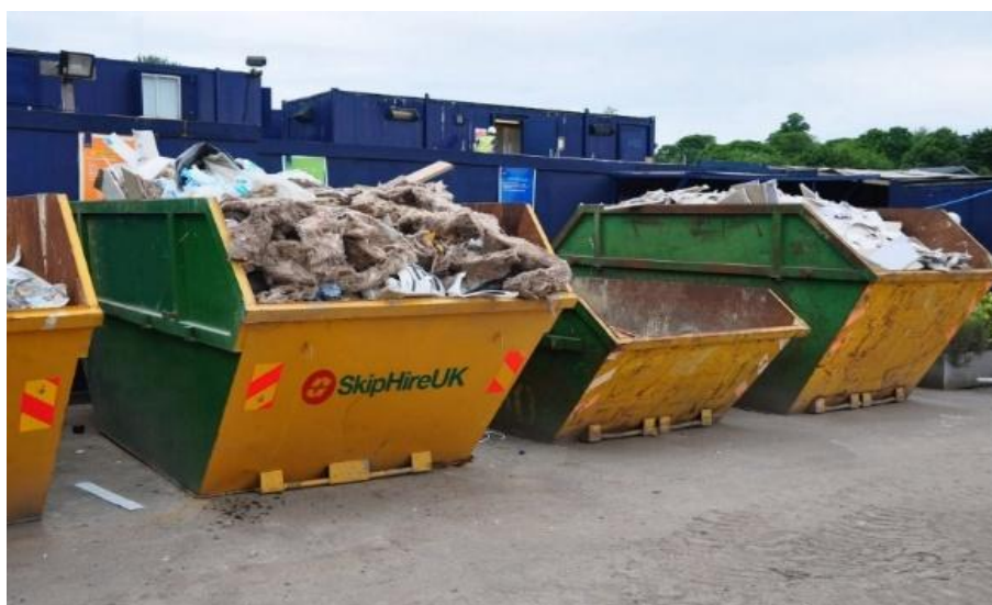
Obrázek 21: Velkoobjemové kontejnery pro stavební odpad [21]
