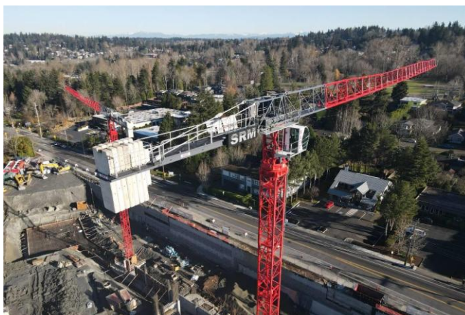
Obrázek 38: Věžový jeřáb SÁEZ TLS 65 8T [38]
