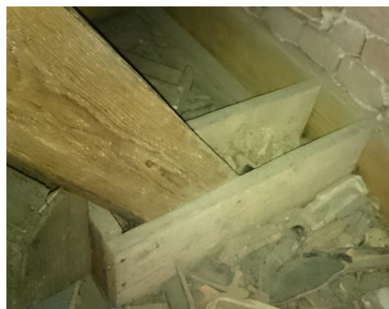
Obr. 25 Připoj sloupku do vazného trámu
