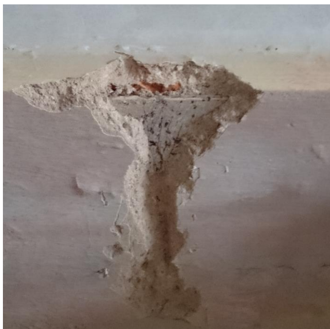
Obr. 20 Sekaná sonda v průvlaku SS1
