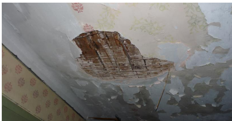
Obr. 19 Příklad porušení spodního pláště
