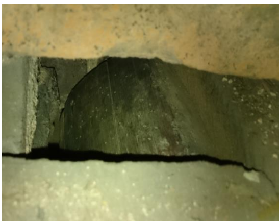
Obr. 24 Uložení vazného trámu
