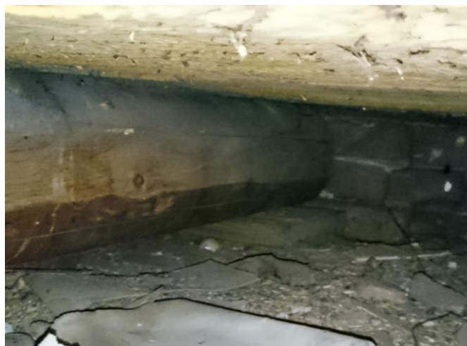
Obr. 15 Uložení hlavního nosného trámu na dřevěnou podložku
