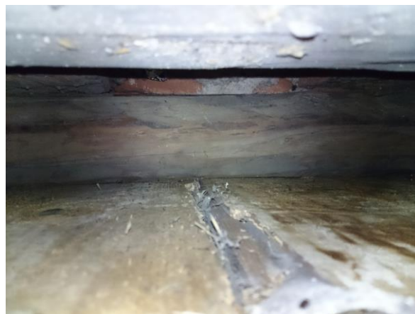
Obr. 18 Náhled do stropní konstrukce 2
