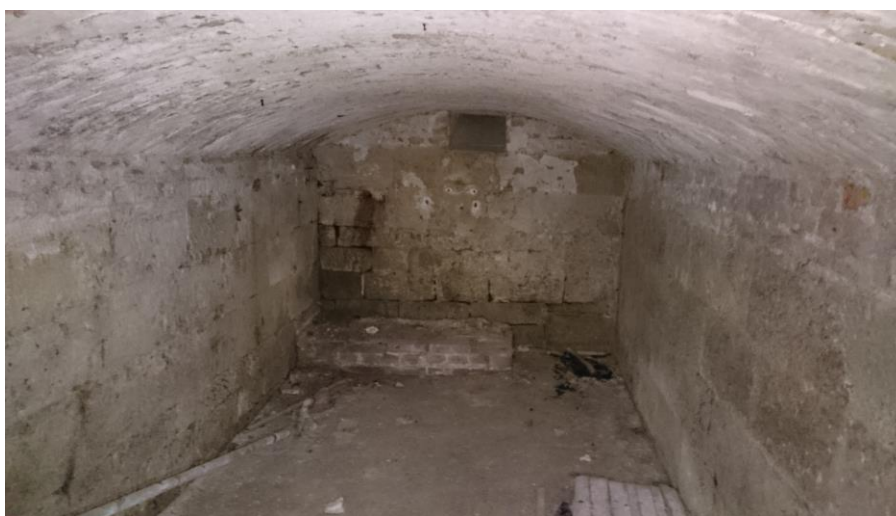
Obr. 16 Pohled do sklepních prostor
