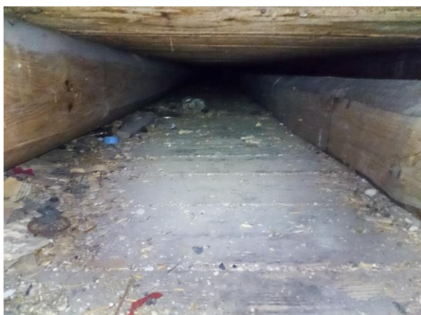
Obr. 17 Náhled do stropní konstrukce 1
