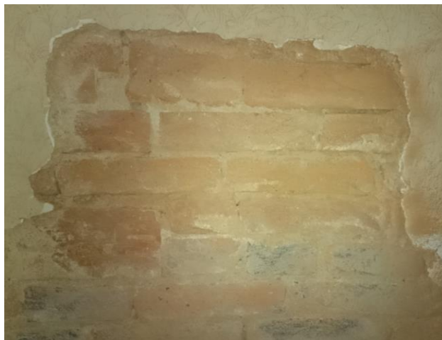
Obr. 13 Zkušební místo svislých nosných konstrukcí (ZK2)
