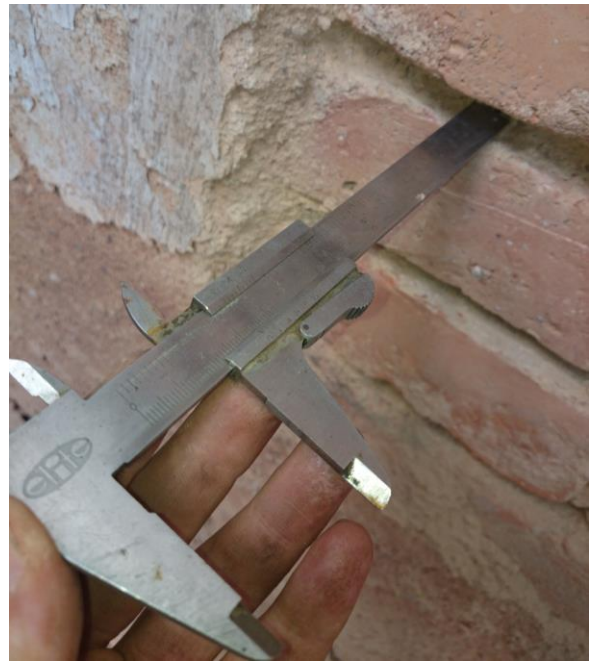
Obr. 37 Měření hloubky vrtu
