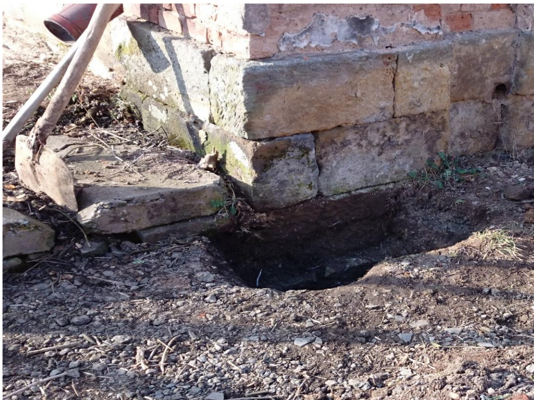
Obr. 32 Vyvrácený kvádr
