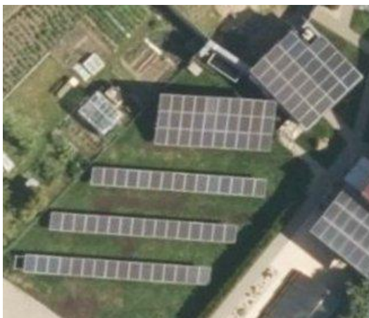
Obrázek 7-1 Pohled na fotovoltaickou elektrárnu
