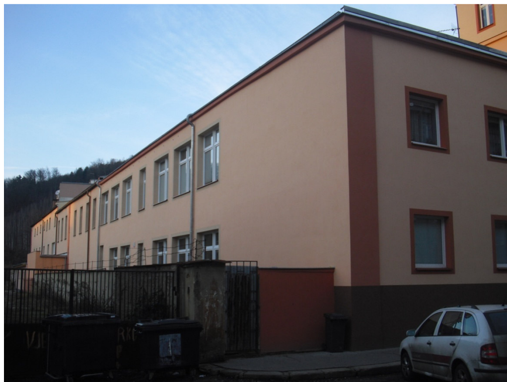
Obr. 6-2: Dvorní budova – pohled z ulice
