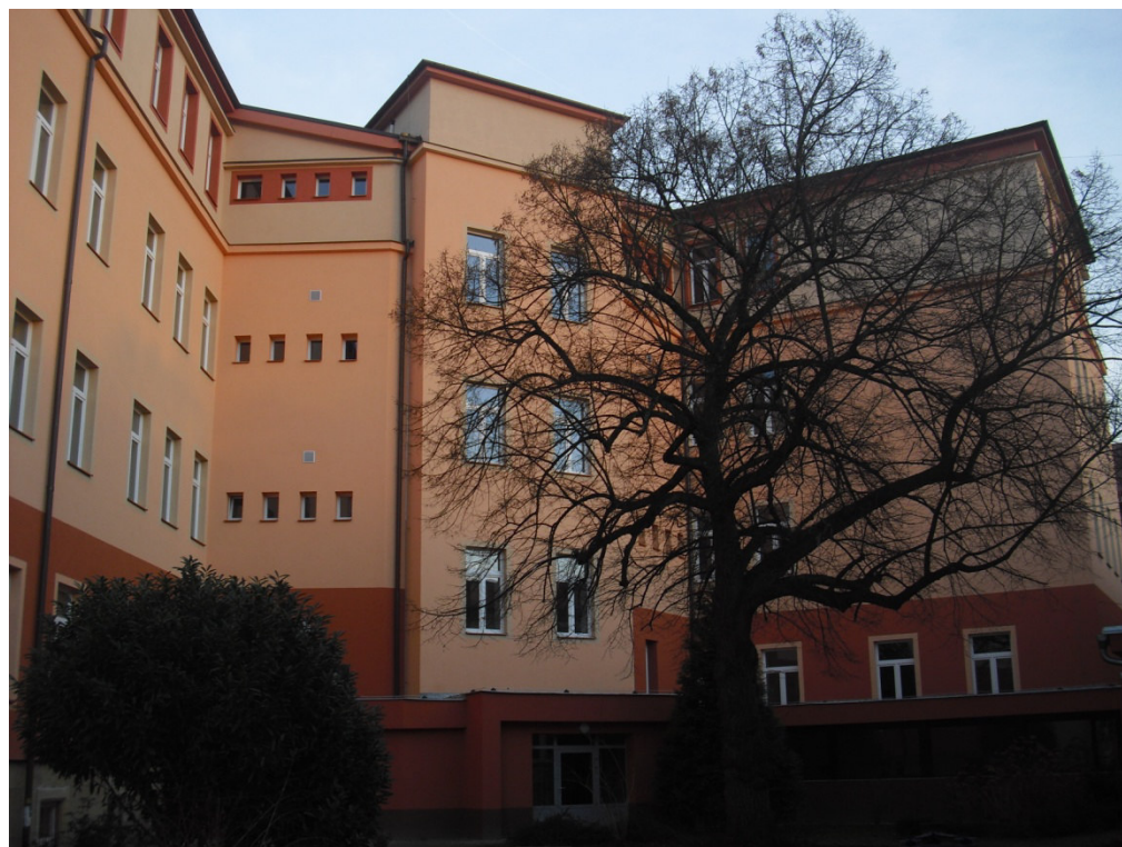
Obr. 6-3: Hlavní budova – pohled ze dvora
