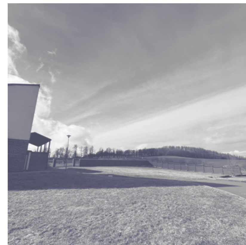
Pohled na prostor, kde je zamýšlena nová smuteční síň
