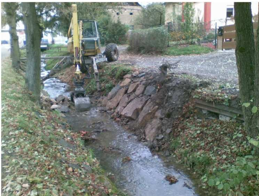
Obr. 3.25. Odstranění škod po povodni v obci Březnice (www.breznice.cz)
