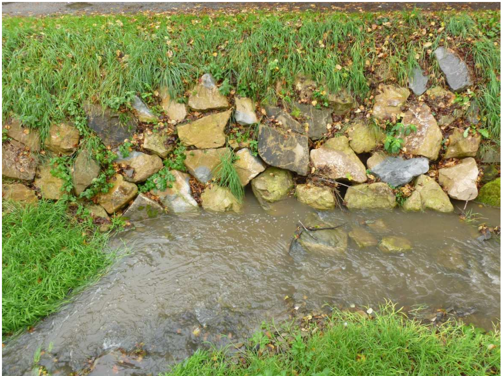
Obr. 3.15. Opevnění koryta v obci Březnice
