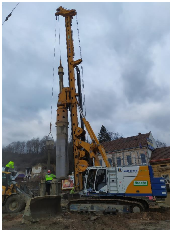
Obr. 21 Vrtná souprava BAUER BG 33 H na Tomkově náměstí – zdroj vlastní
