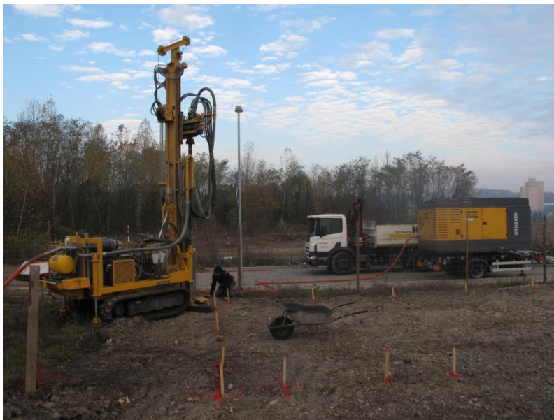
Obr. 7 Vrtání vrtu pro tepelné čerpadlo [16]
