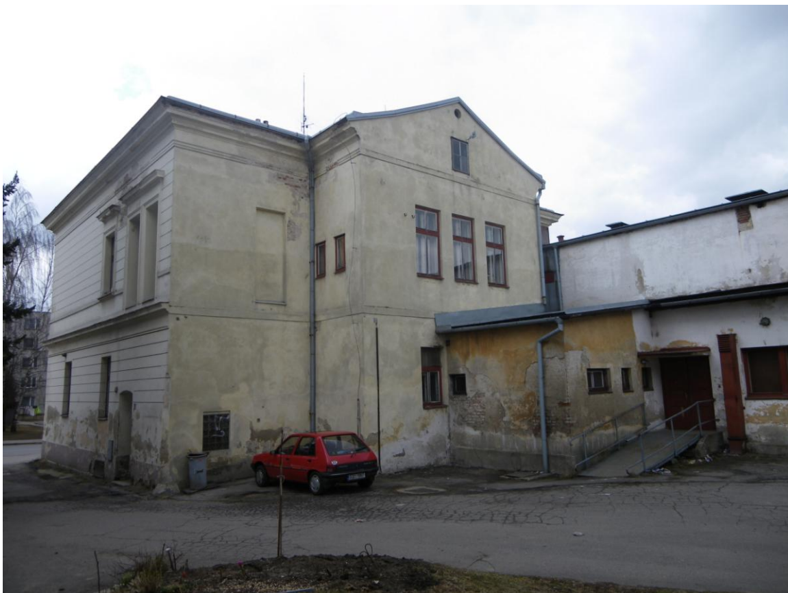
Bytový dům č.p. 200 – pohled ze dvora
