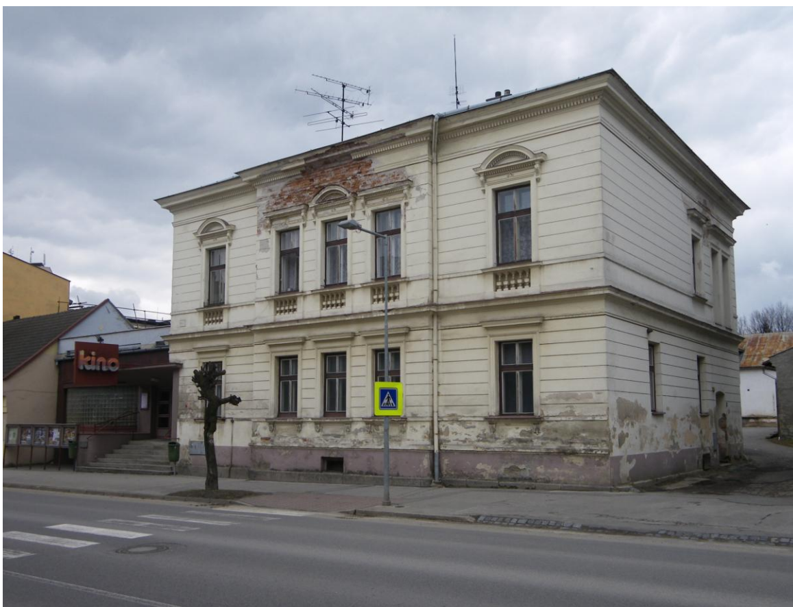
Bytový dům č.p. 200 – pohled od silnice
