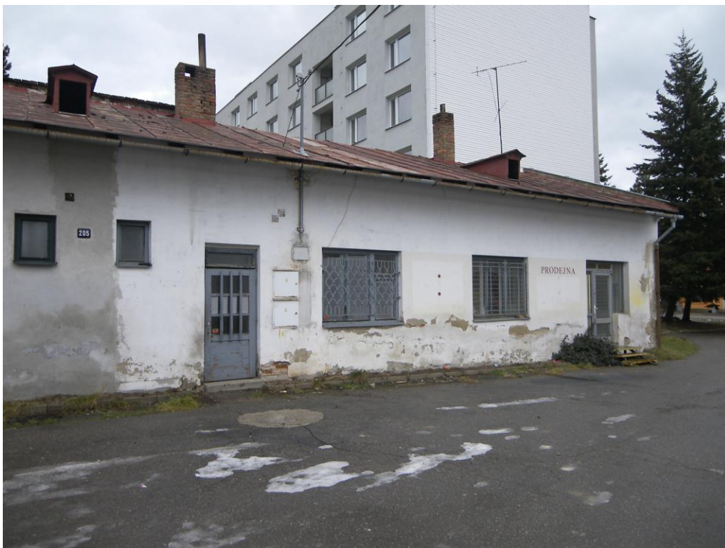
Budova služeb a administrativy č.p. 205 – pohled ze dvora
