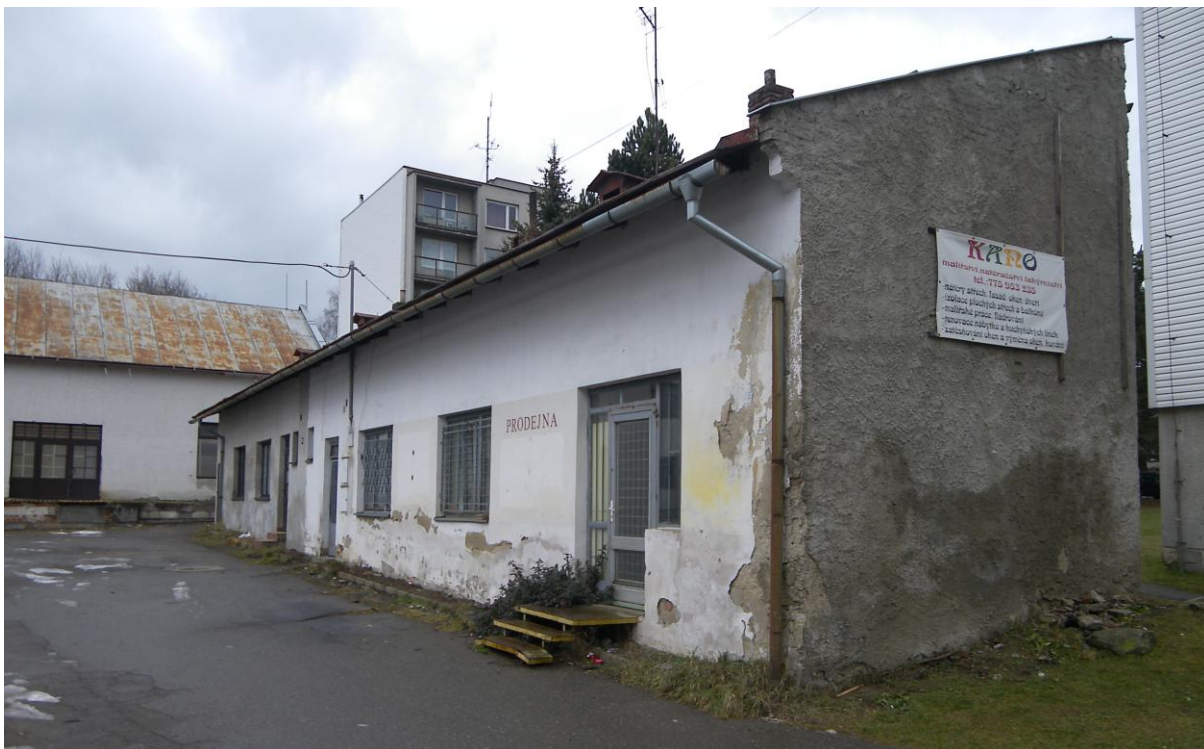
Budova služeb a administrativy č.p. 205 – pohled od silnice
