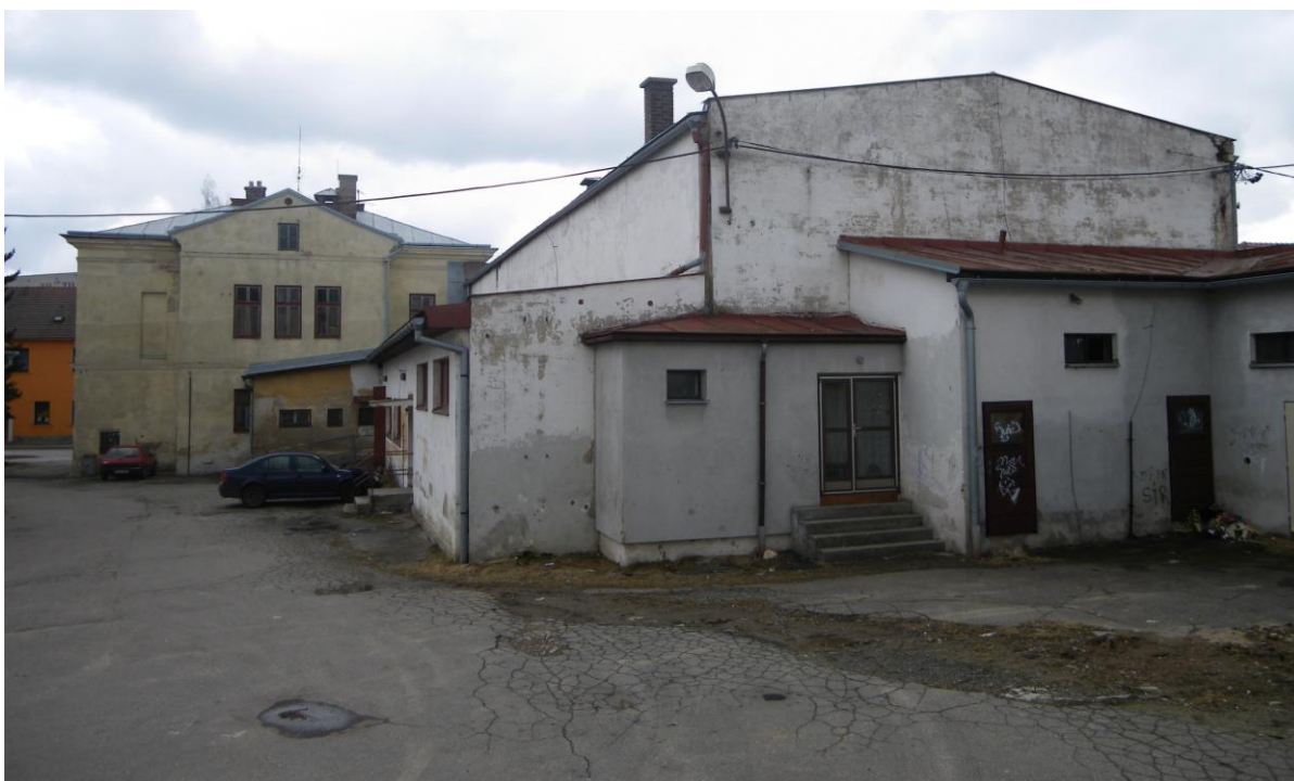
V popředí zadní část budovy kina č.p. 204 a navazující skladovací prostory - pohled ze dvora
