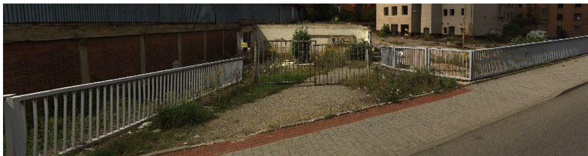
Obrázek 7 Vjezdová brána do areálu staveniště (autor)
