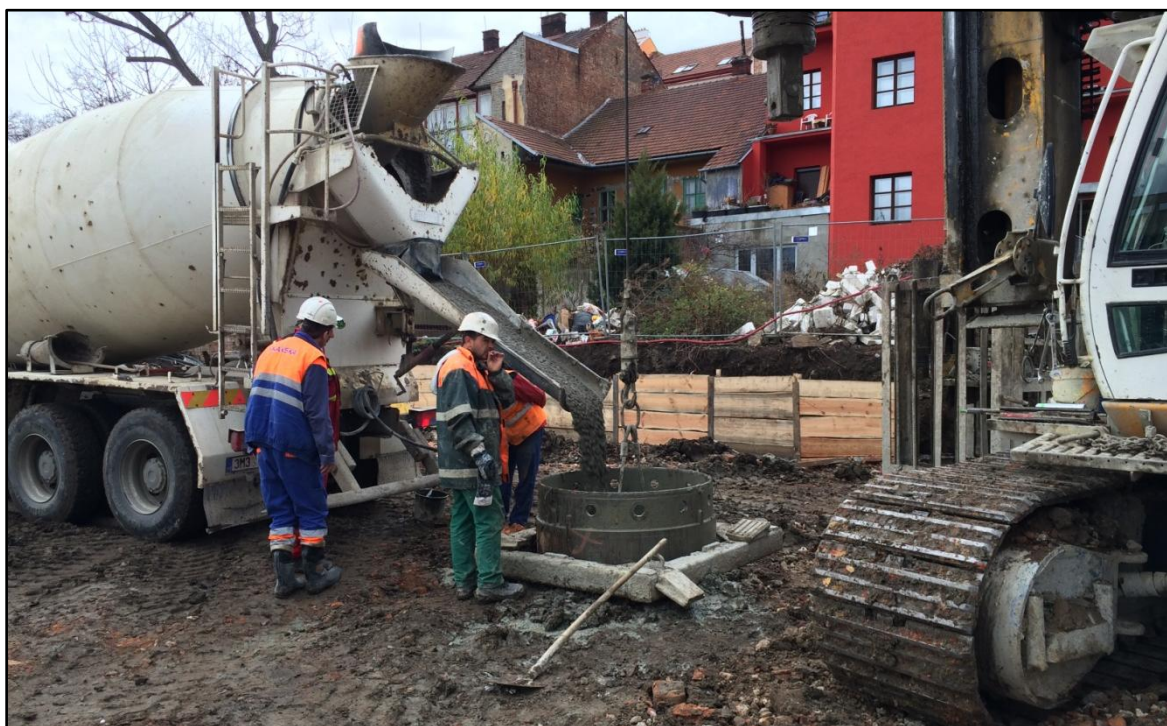
Obrázek 64 Betonáž piloty http://www.geovrt.sk/piloty
