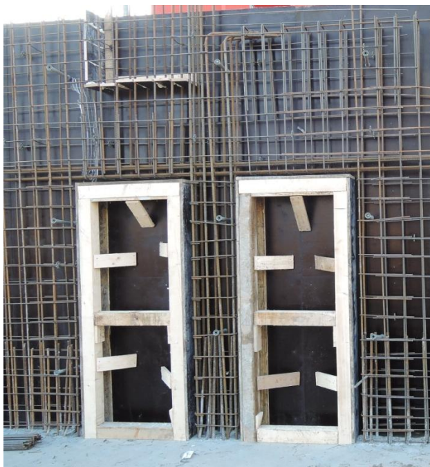
Obrázek 90 Zajištění otvorů proti protečení betonu (autor)
