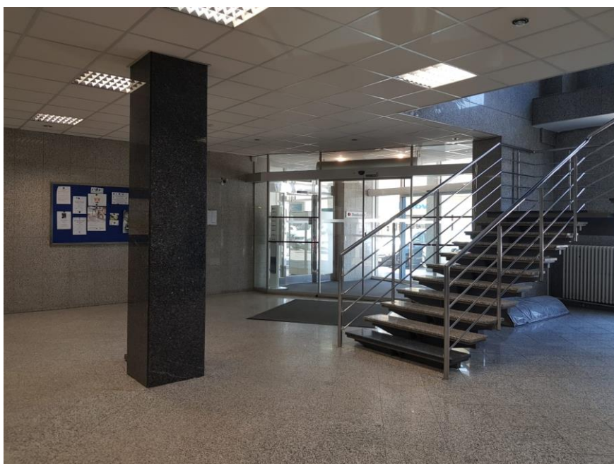
Obrázek 15 - přízemní chodba (Vlastní práce, 2023)
