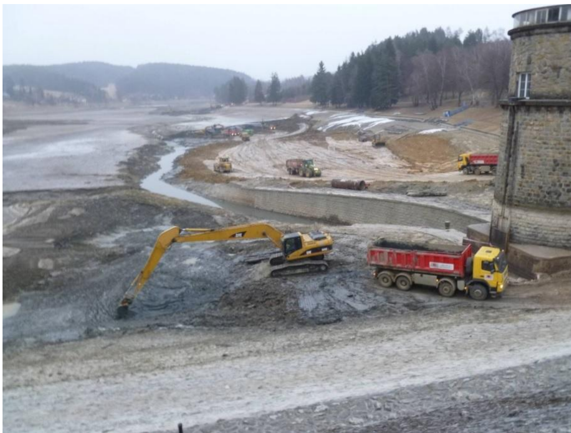
Obr. č. 14 - Těžba nánosů u výpustného objektu [14]
