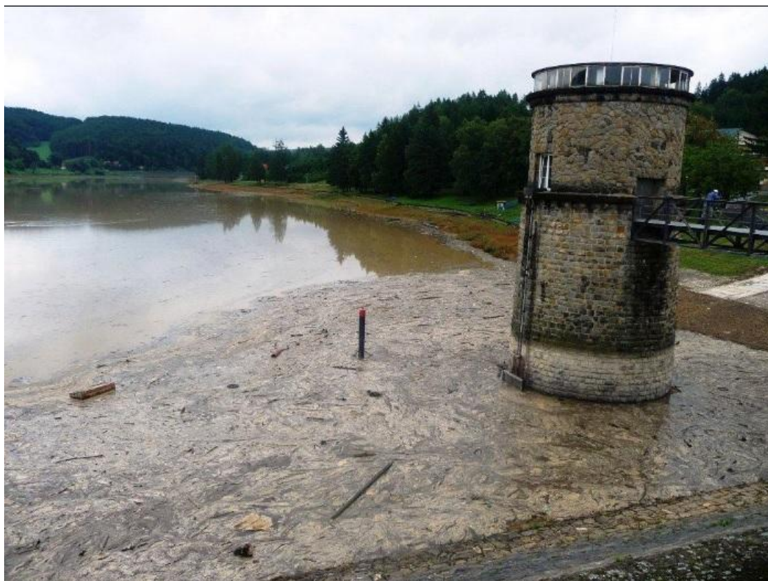
Obr. č. 13 - Nánosy kolem věže přehrady po povodních [14]
