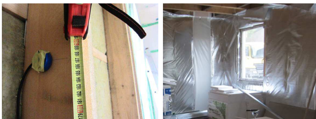
Obr. 44) Detail výškového umístění sond Elbez ve sloupku v místnosti 1R (obvodová stěna E1 difúzně uzavřená) a pohled do řešené místnosti
