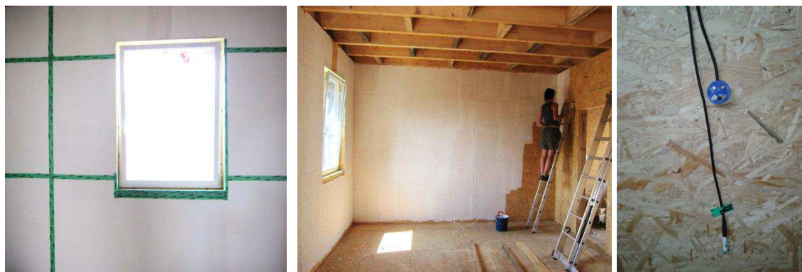
Obr. 45) Pohled na řešenou stěnu v místnosti 2E (obvodová stěna E2 difúzně otevřená, OSB desky s latexovým nátěrem) s pohledem na sondu Elbez pro měření teploty a vlhkosti dřeva a čidla pro měření relativní vlhkosti a teploty vzduchu Ahlborn
