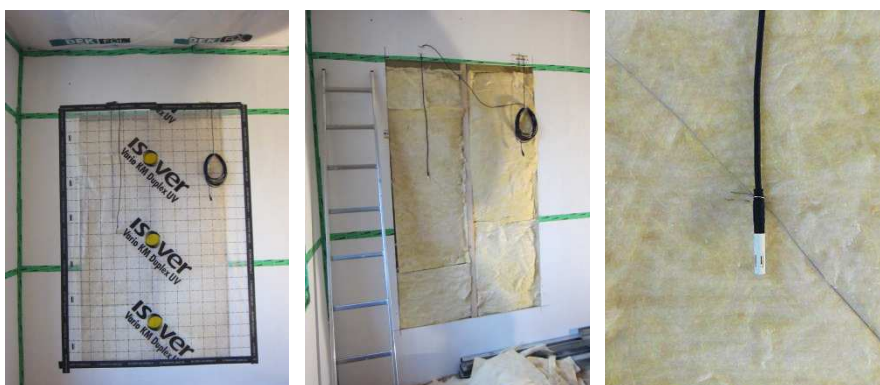
Obr. 46) Pohled na řešenou stěnu v místnosti 2E (obvodová stěna E2 difúzně otevřená, parotěsnicí vrstva tvořená parozábranou s proměnnou ekvivalentní difúzní tloušťkou) s pohledem na umístění čidlo pro měření relativní vlhkosti a teploty vzduchu Ahlborn, sonda Elbez již zabudovaná ve skladbě
