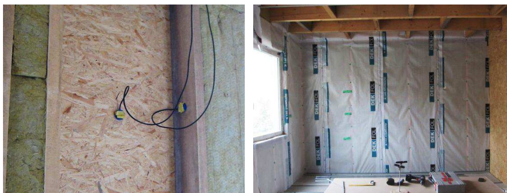
Obr. 43) Umístění sond Elbez ve sloupku a OSB desce v místnosti 1E (obvodová stěna E1 difúzně uzavřená) a pohled do řešené místnosti
