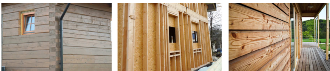
Obr. 17) Konstrukční systémy dřevostaveb – moderní srubová stavba a sloupkový systém [zdroj: archiv autora]
