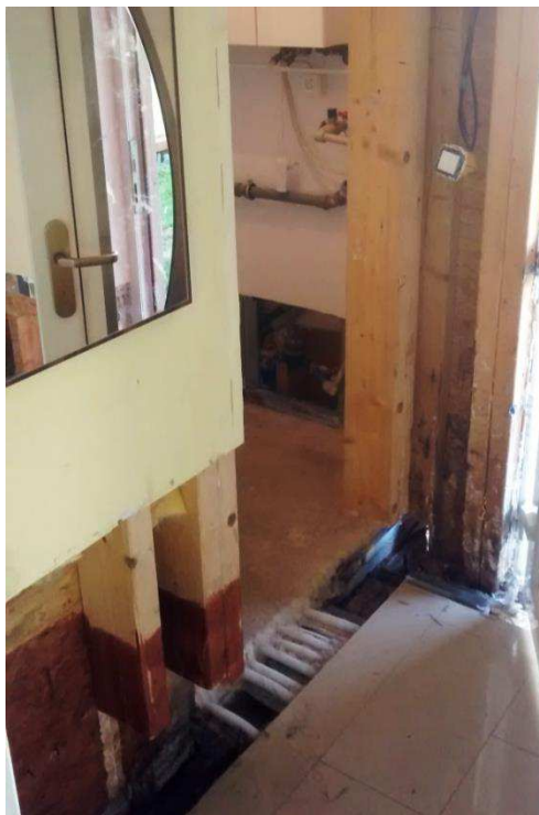
Obr. 61) Sanace odřezáním degradovaných částí dřevěných sloupků [zdroj: archiv autora]
