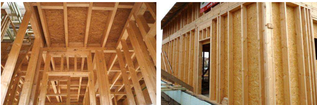
Obr. 16) Dřevostavba, sloupkový konstrukční systém – řezivo a OSB desky [zdroj: archiv autora]
