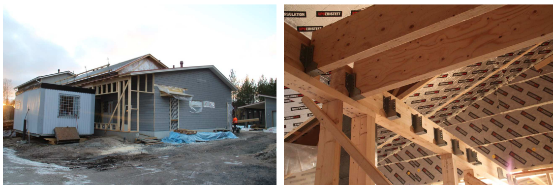
Obr. 30) Výstavba rodinného domu ve čtvrti Energy Efficiency Quarter in Ritaharju [zdroj: archiv autora]
