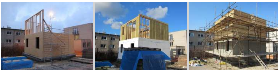
Obr. 36) Dřevostavba EXDR1, systém „two by four“, Platform Frame, průběh výstavby[zdroj: archiv autora]
