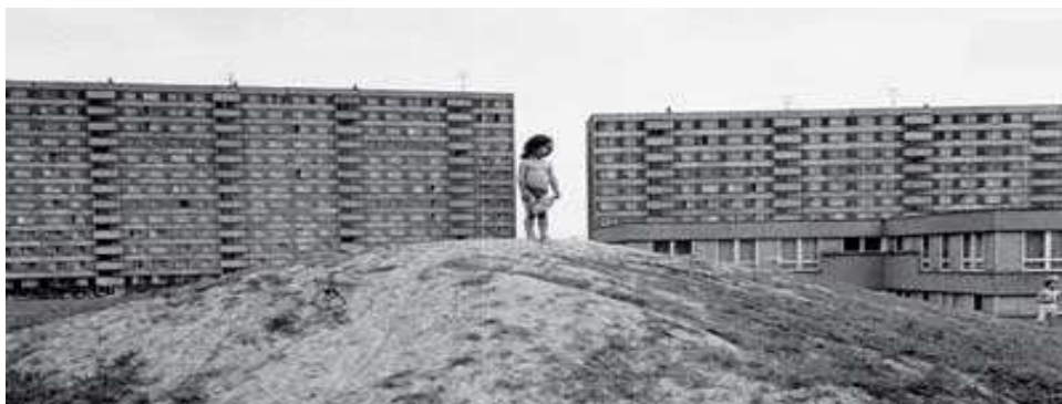
Obr. č. 7 Sídlíště z panelových domů (13)
