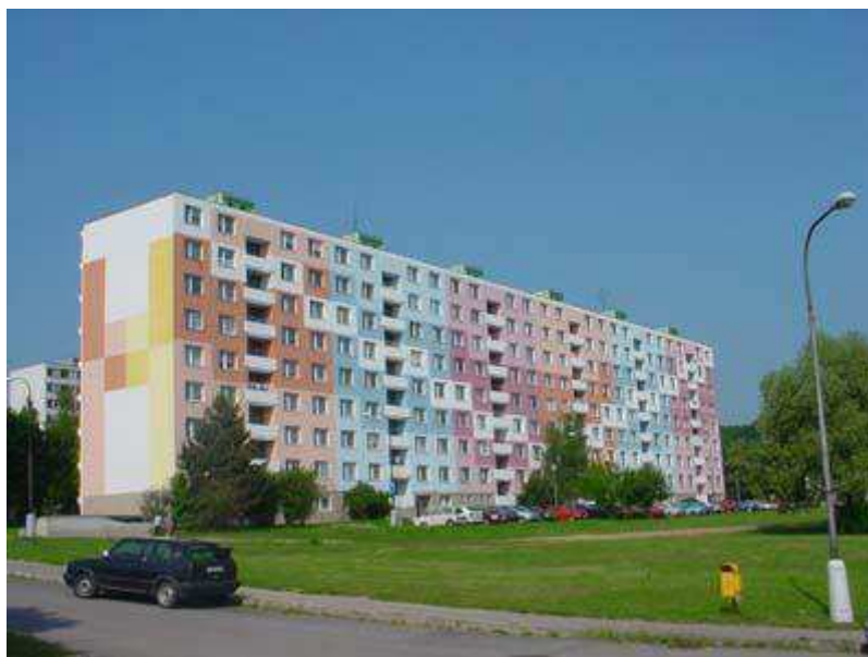
Obr. č. 12 Panelový dům po rekonstrukci (15)
