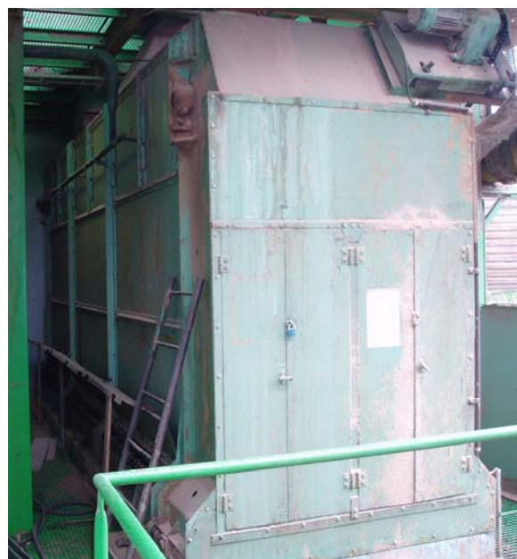
Obr. 4.3 Pohled na hlavní zásobovací bunkr
