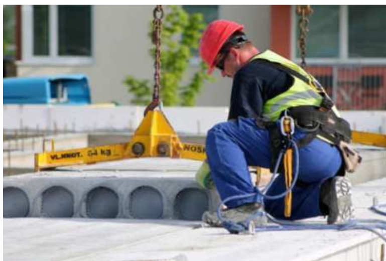
Obr. č.64 montáž panelů spiroll samosvornými kleštěmi
