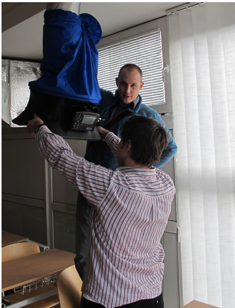
Obr. 51 Měření průtoku vzduchu na přívodním potrubí
