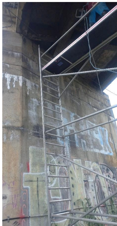
Obrázek 31: Konstrukce lešení u OP2
