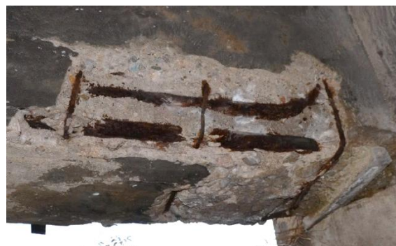
Obrázek 38: Sekaná sonda trámu č. 4 u uložení S5
