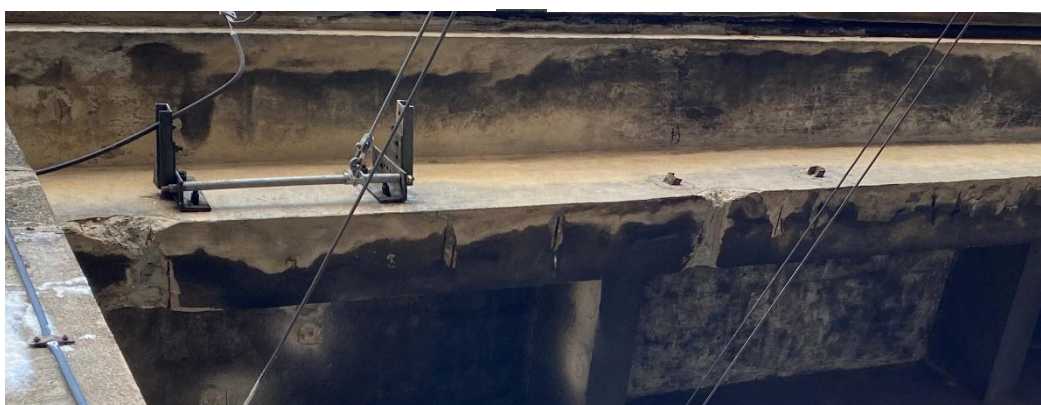
Obrázek 42: Zapravená místa po sekaných sondách
