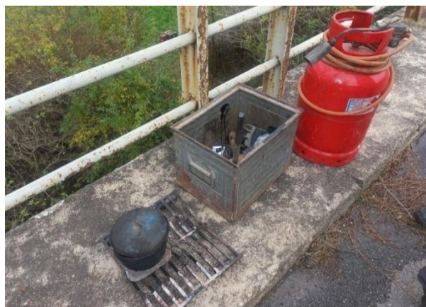
Obrázek 58: Příslušenství potřebné k řádné opravě průvrtu vozovkou
