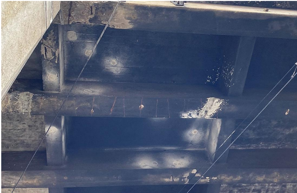
Obrázek 45: Zkušební místa tvrdoměrného měření na nosné konstrukci
