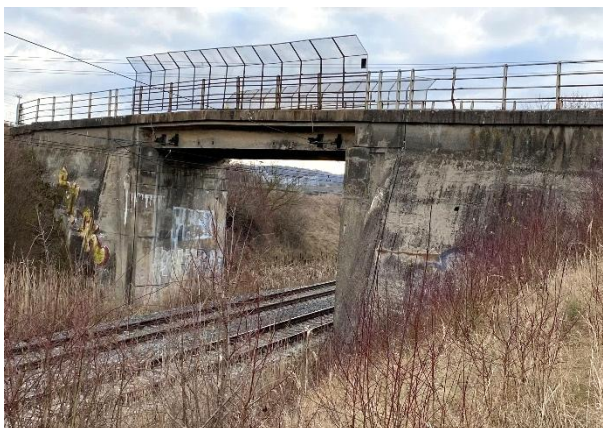
Obrázek 10: Pohled na levou stranu mostu
