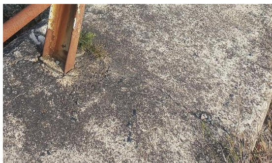
Obrázek 130: Trhlina s vegetací na levé římse
