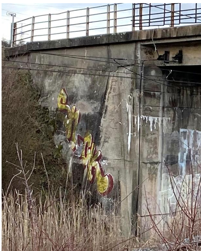
Obrázek 99: Levé mostní křídlo OP2
