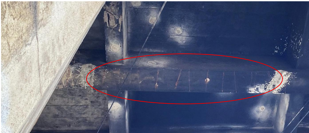
Obrázek 33: Viditelné vyznačení smykové výztuže trámu po georadarovém měření
