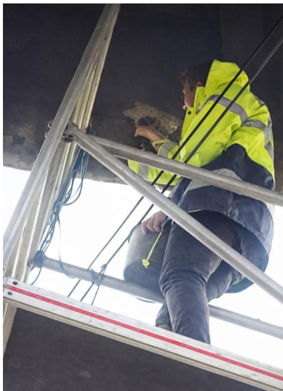
Obrázek 40: Zapravování po sekaných sondách
