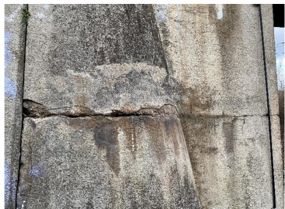
Obrázek 115: Detail vydrolené pracovní spáry křídla OP1
