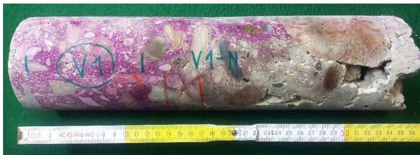
Obrázek 60: Fotodokumentace vývrtnu V1
