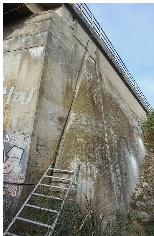
Obrázek 100: Pravé mostní křídlo OP2
