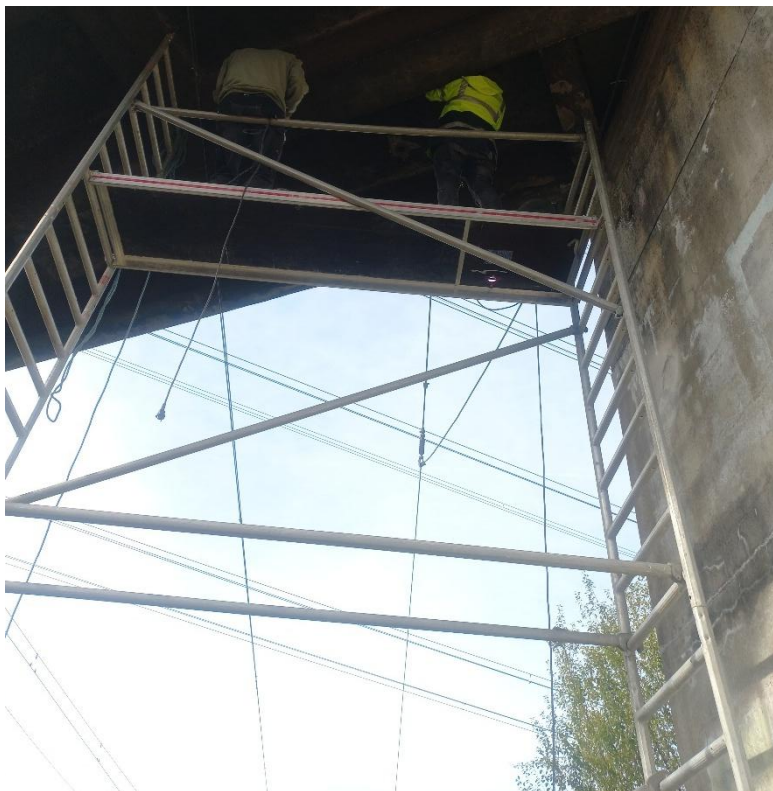
Obrázek 30: Provádění průzkumu na lešení
