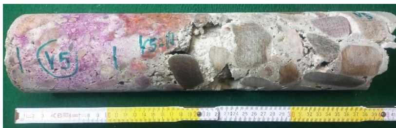
Obrázek 64: Fotodokumentace vývrtu V5
