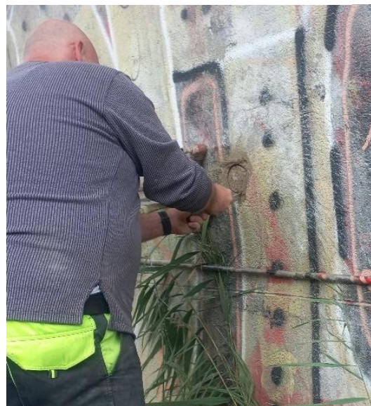
Obrázek 48: Vytahování uvízlého vývrtnu
