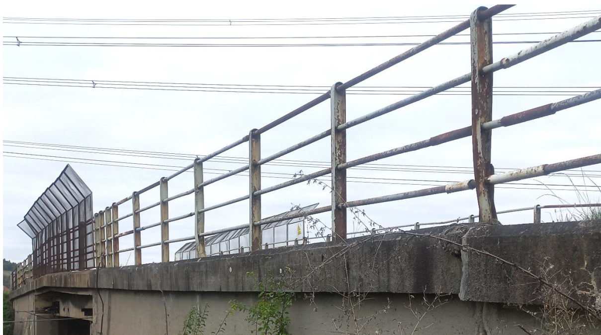
Obrázek 159: Celkový pohled na zábradlí levé části mostu
