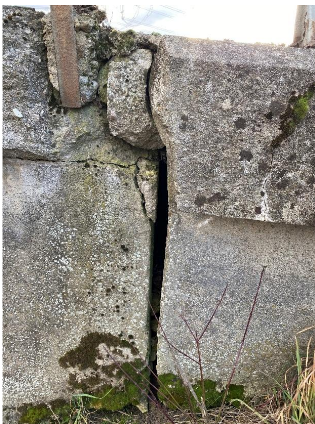
Obrázek 124: Přechodová oblast u levého křídla DP1
