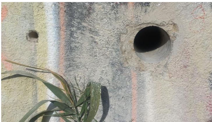
Obrázek 49: Místo po provedení jádrového vývrtnu před zapravením
