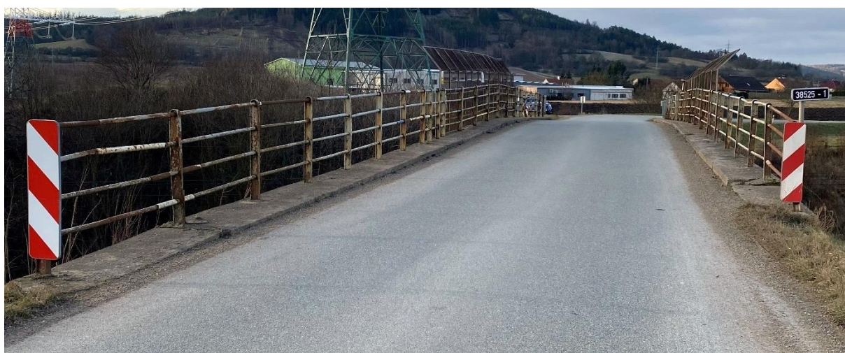
Obrázek 9: Pohled na mostní konstrukci proti směru staničení
