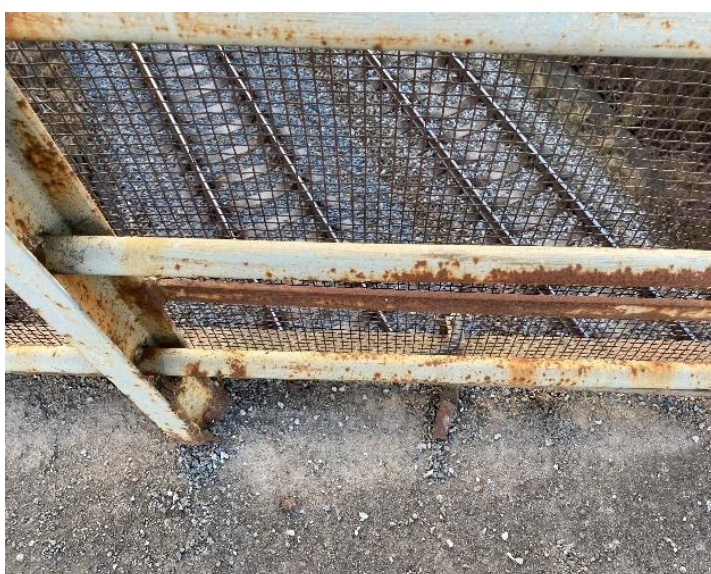
Obrázek 179: Upevnění ukolejnění pravé protidotykové zábrany
