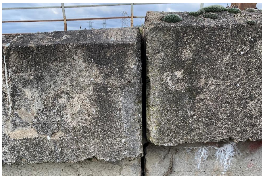
Obrázek 148: Spára pravé římsy – boční pohled
