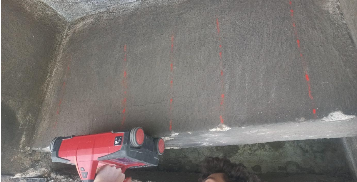
Obrázek 32: Ukázka práce s georadarem – lokalizace výztuže příčnicku č.4
