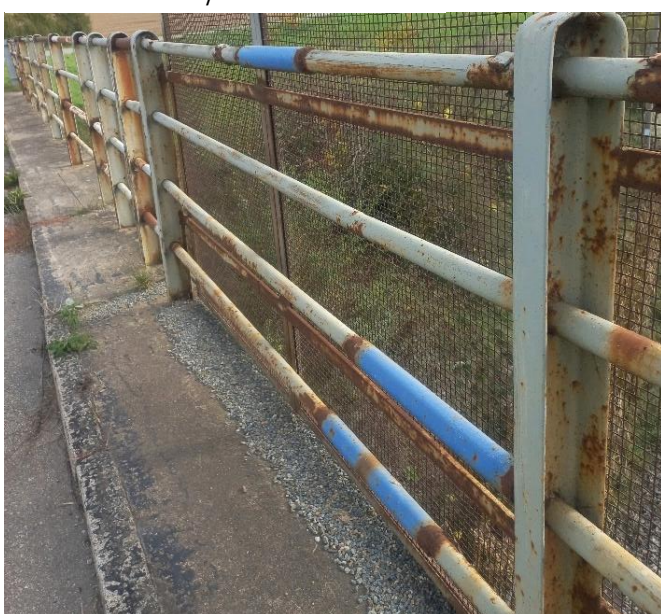
Obrázek 180: Opravy pravého zábradlí
