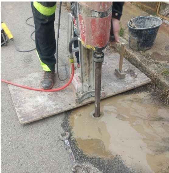
Obrázek 52: Realizace průvrtu vozovkou
