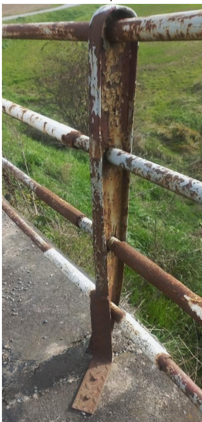
Obrázek 184: Dodatečné znovu přikotvení sloupku pravého zábradlí
