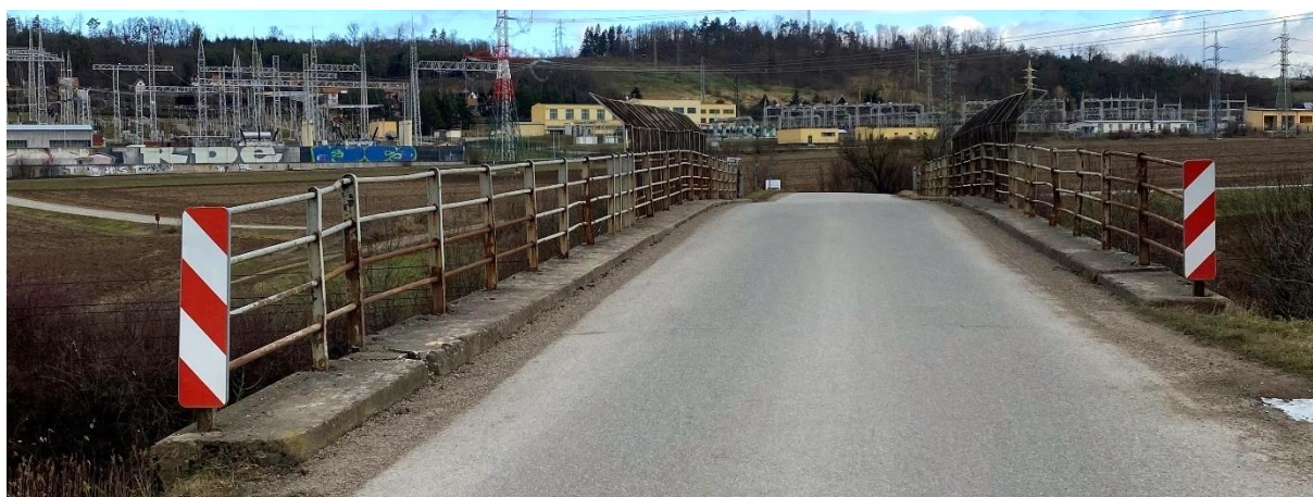
Obrázek 8: Pohled na mostní konstrukci ve směru staničení (od Hradčan)
