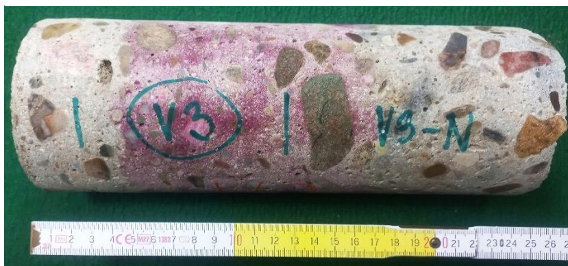
Obrázek 62: Fotodokumentace vývrtnu V3
