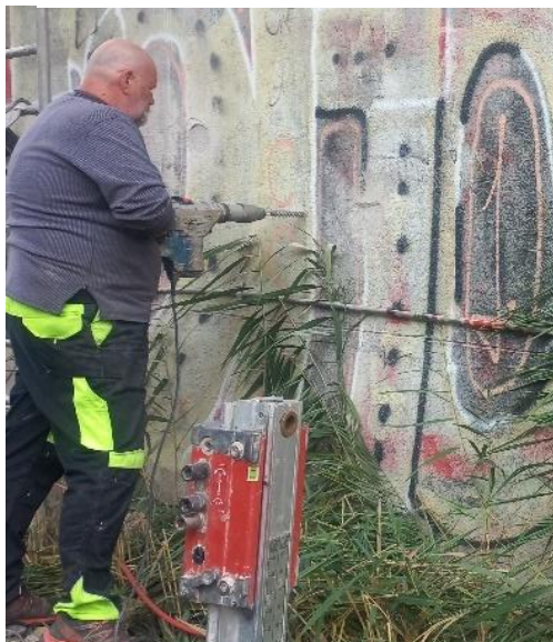
Obrázek 47: Příprava pro uchycení vrtačky
