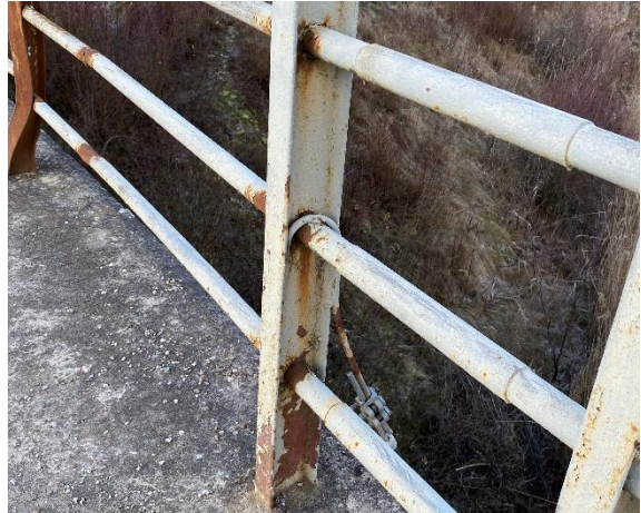
Obrázek 164: Detail připevnění uzemnění zábradlí
