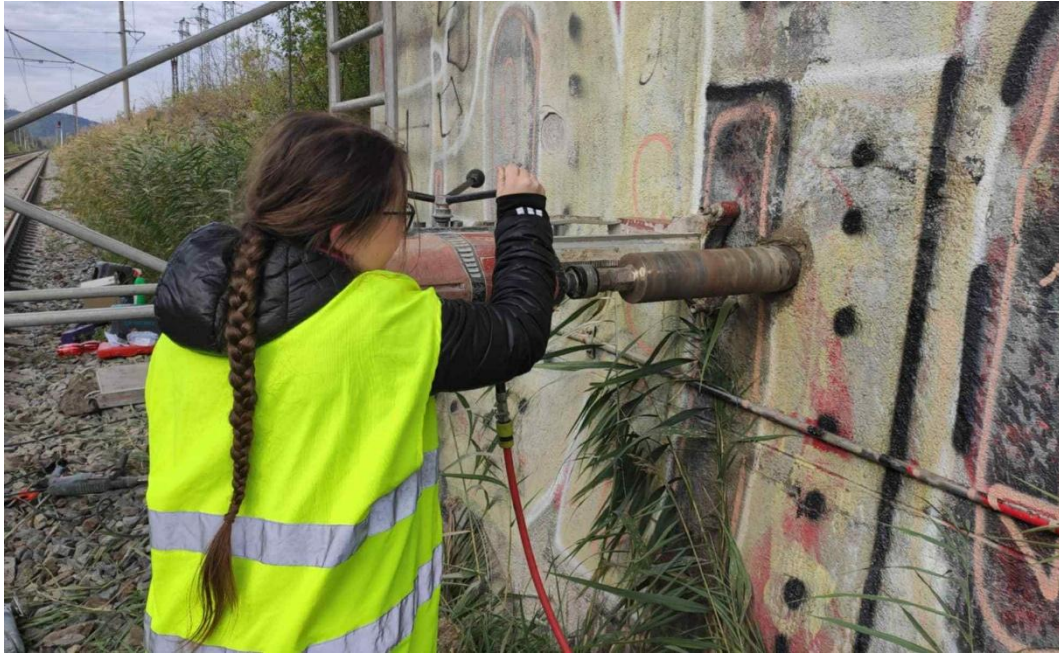
Obrázek 46: Vrtání jádrového vývrtnu na dříku OP2
