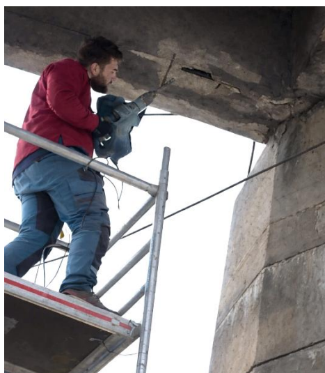
Obrázek 34: Realizace sekané sondy trámu č.1 u uložení na OP2
