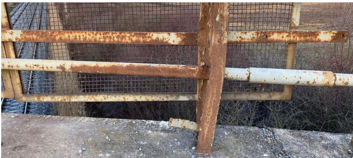
Obrázek 168: Levá protidotyková zábrana u směru na Drásov - vyšší mezera mezi zábranou a římsou
