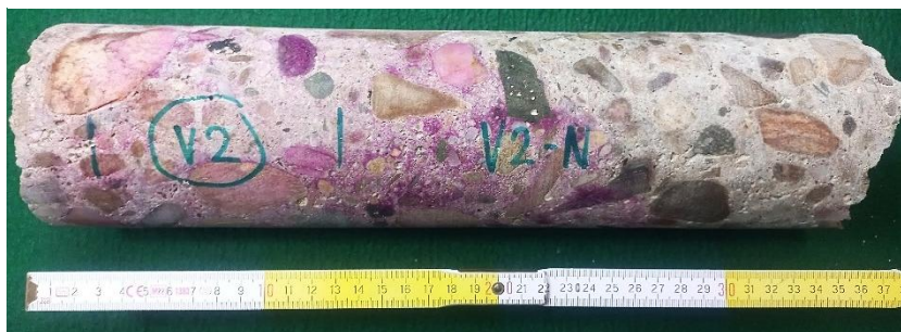
Obrázek 61: Fotodokumentace vývrtnu V2
