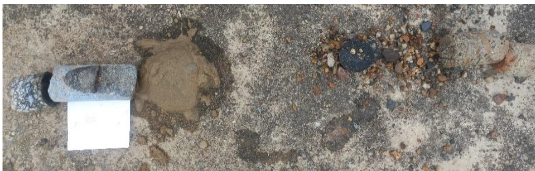
Obrázek 54: Detail souvrství vozovky z odebraného průvrtu
