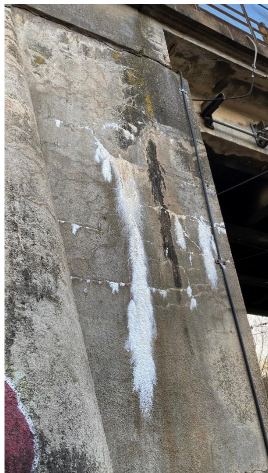
Obrázek 109: Nejrozsáhlejší inkrustace na levém křídle OP2 a síť trhlinek
