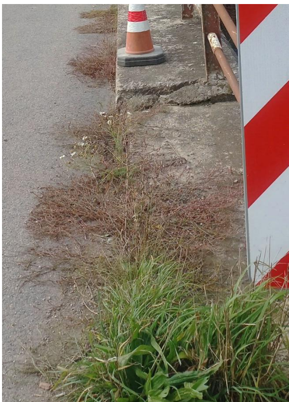
Obrázek 142: Vegetace u levé římsy při pohledu proti směru staničení
