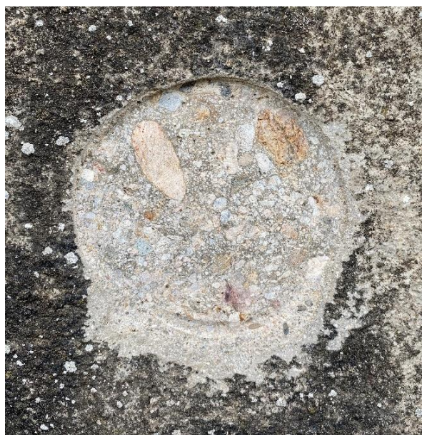
Obrázek 44: Detail řádně připraveného zkuš. místa
