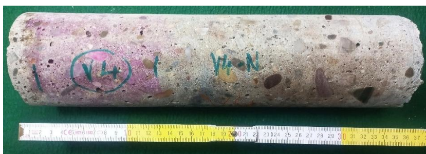
Obrázek 63: Fotodokumentace vývrtnu V4
