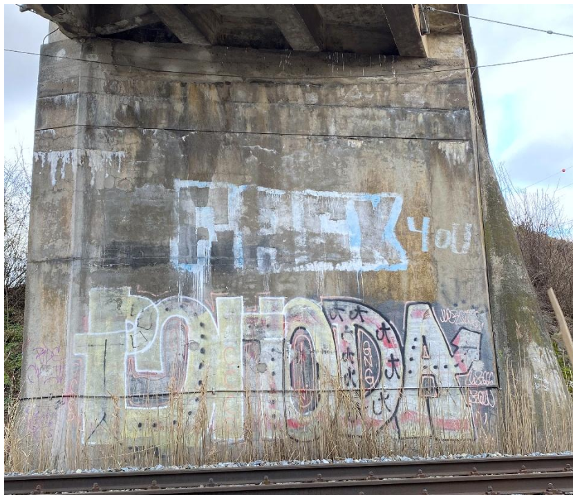
Obrázek 98: Pohled na drásovskou opěru (OP2)
