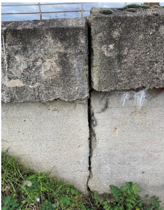
Obrázek 116: Přechodová oblast u pravého křídla OP1
