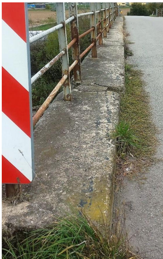
Obrázek 126: Vegetace u levé římsy mostu ve směru staničení
