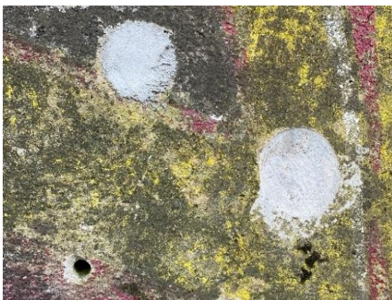
Obrázek 57: Opravené místo odběru vývrtnu na křídle OP2
