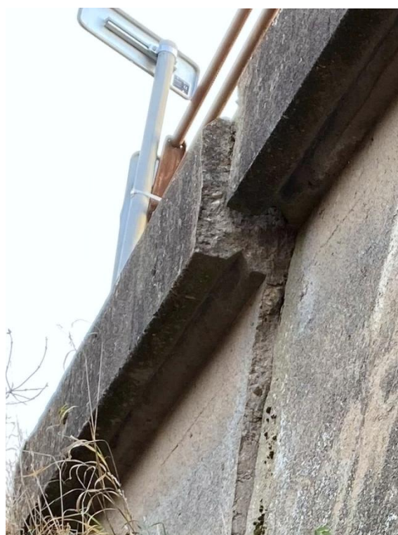
Obrázek 144: Boční pohled na rozpad levé římsy
