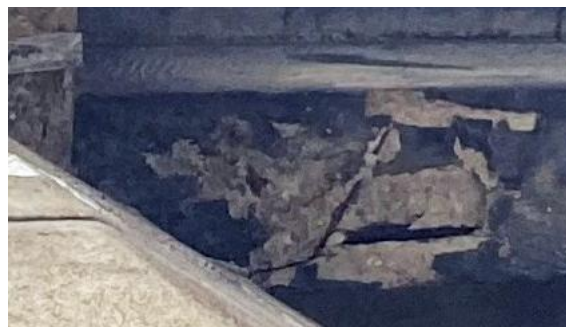
Obrázek 39: Sekaná sonda příčnicku č. 1 S6
