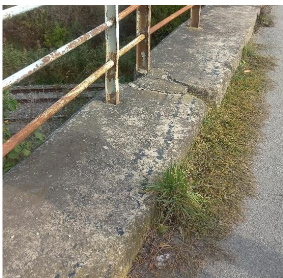
Obrázek 24: Vegetace u levé římsy
