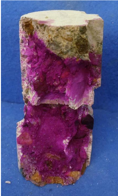
Obrázek 74: Zkouška fenolftaleinem na dvou vzorcích po sobě jdoucích z vývrtu V6
