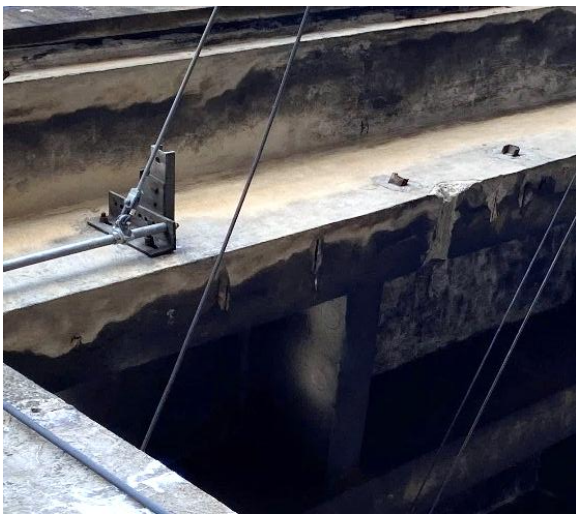
Obrázek 19: Uchycení lan vynášející kabely dráhy – stopy po starém uchycení
