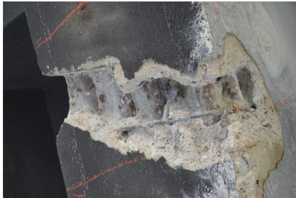
Obrázek 3: Ukázka sekané sondy mostního trámu
