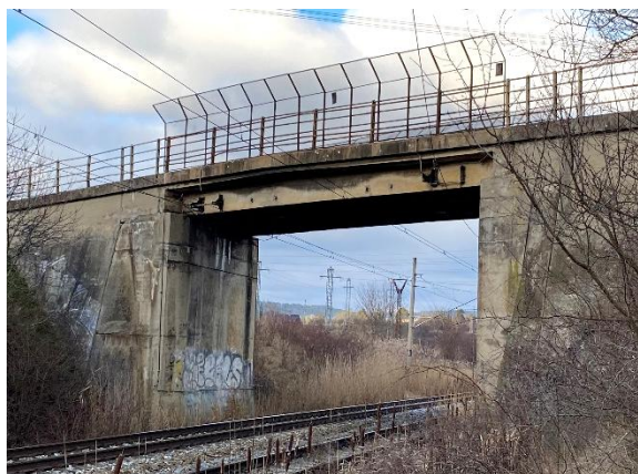
Obrázek 11: Pohled na pravou stranu mostu
