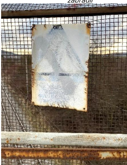
Obrázek 178: Nečitelná výstražná tabulka na pravé zábraně
