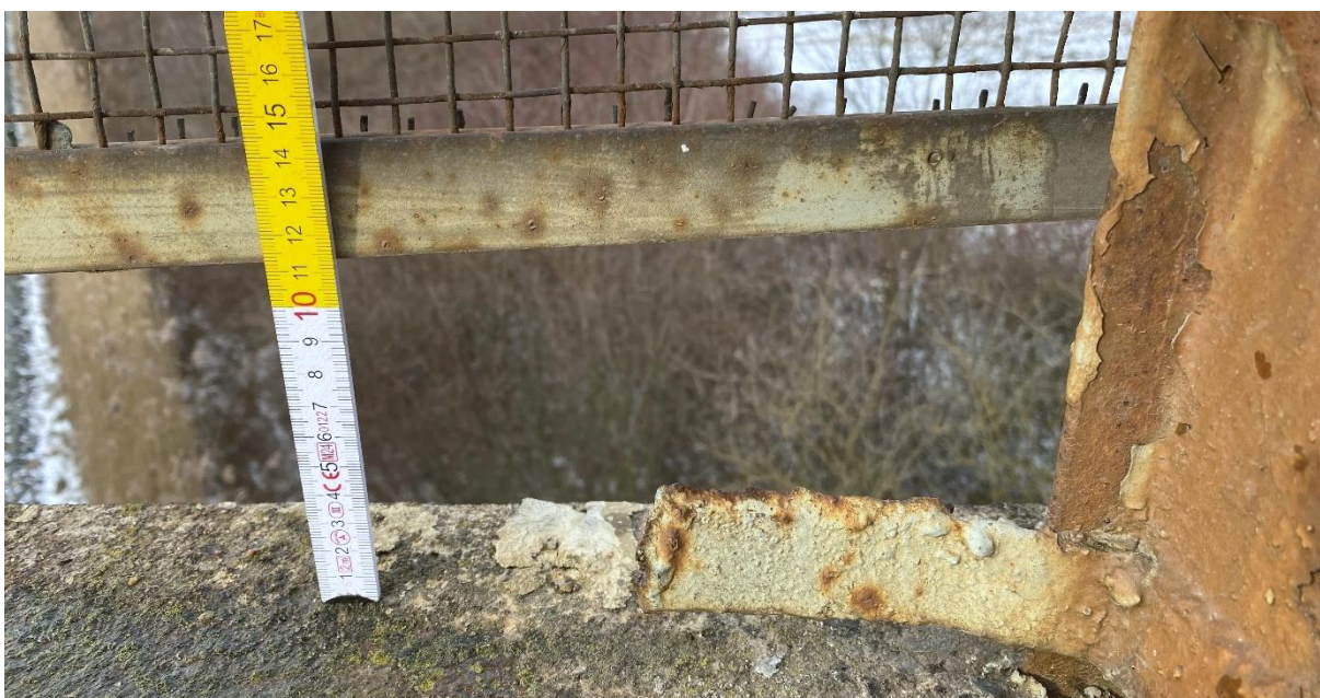
Obrázek 169: Mezera přibližně 11,5cm mezi levou protidotykovou zábranou a římsou
