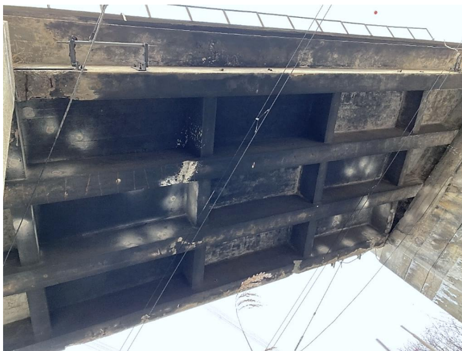
Obrázek 14: Podhled nosné konstrukce mostního objektu
