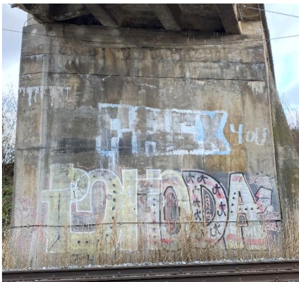
Obrázek 12: Drásovská opěra (OP2)
