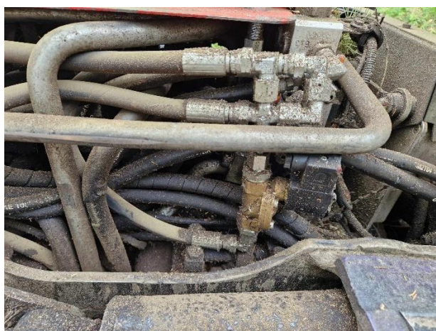
Obr. 19 Elektromagnetický ventil umístěný na hlavici harvestoru.
