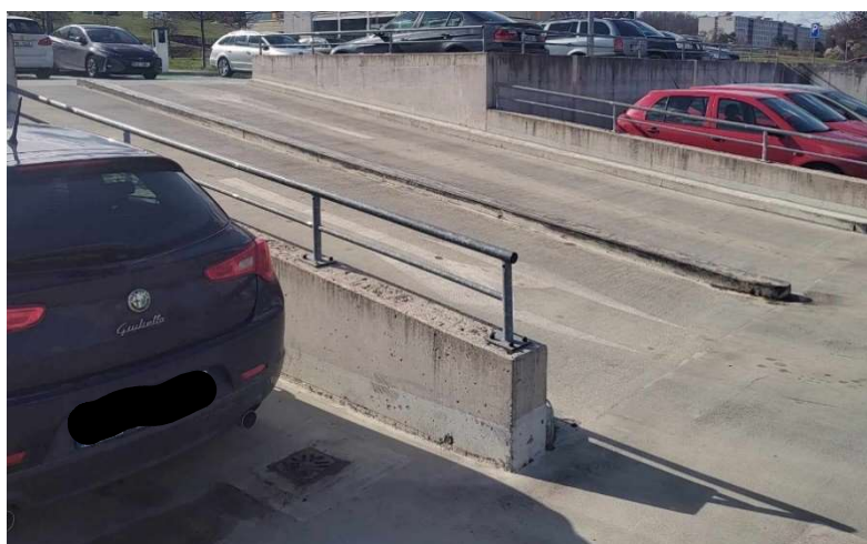
Obrázek 4.5 Rampa u parkoviště budovy T12.
