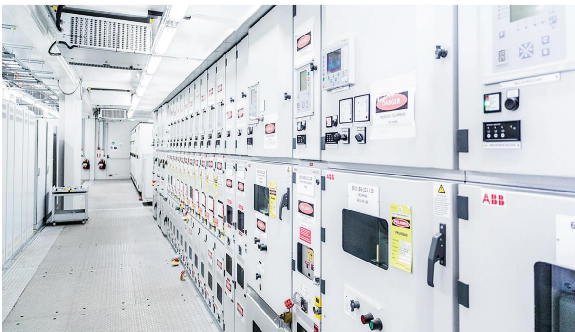
Obrázek č. 3: Příklad vnitřního vzhledu eHouse
