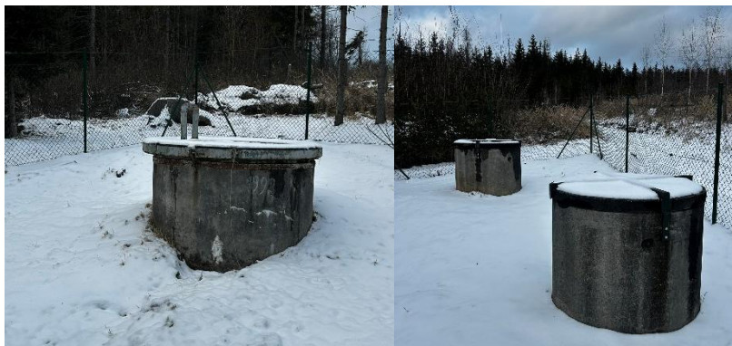
Obr. 2.6 Příklad podzemního zdroje – jímací studny [autor]
