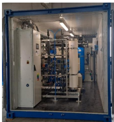
Obr. 3.3 Vystrojení kontejnerové úpravný vody [29]
