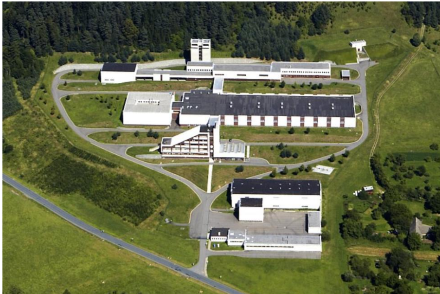
Obr. 2.1 Úpravna vody Švařec – ilustrační foto [2]
