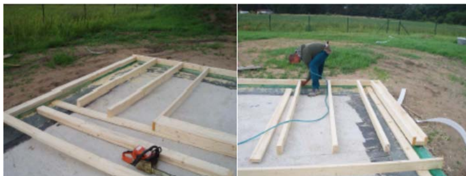
Obr. 7: Montáž rámovej konštrukcie
