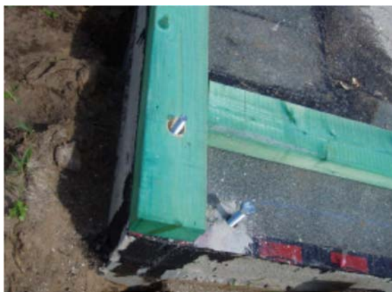
Obr. 5: Osadenie kotviaceho hranola
