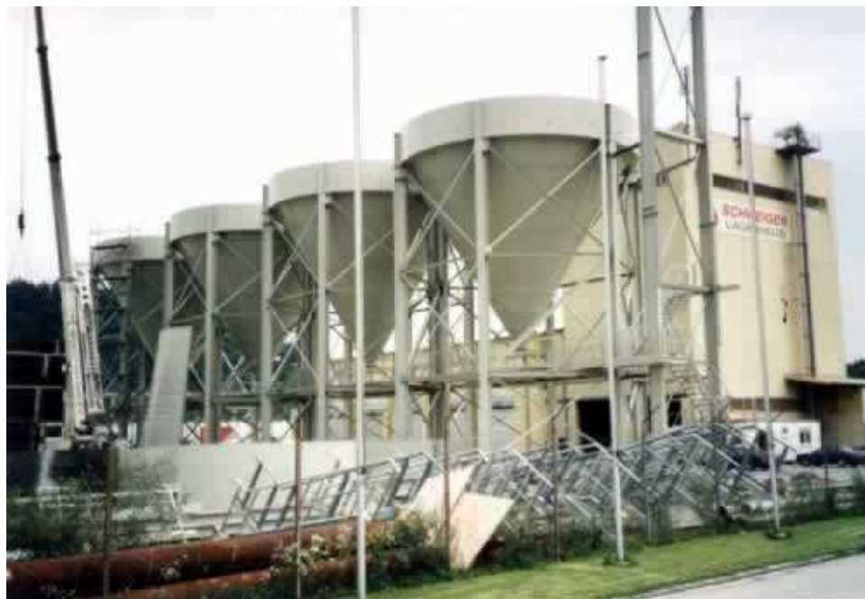
Obrázek 7: OK Betonárky Deggendorf (Německo) (Zdroj (7))
