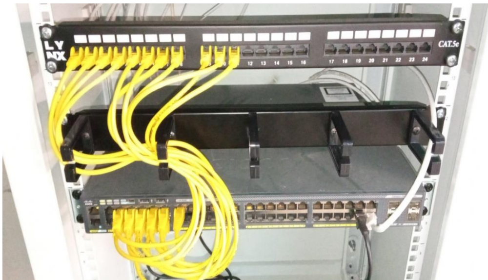
Obrázek 17: Zapojení přepínače v rozvaděči
