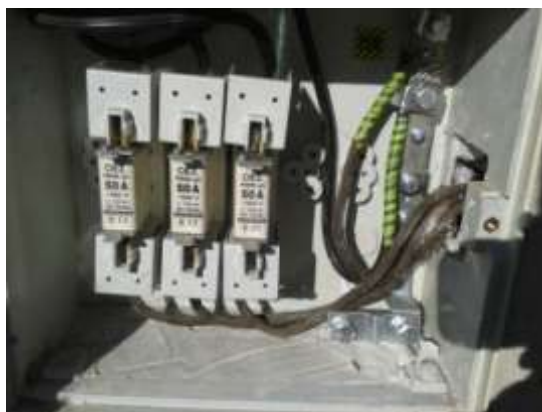
Obrázek 1 Vnitřní uspořádání přípojkové skříně
