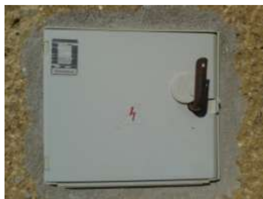
Obrázek 2 Přípojková pojistková skříň s příslušným klíčem
