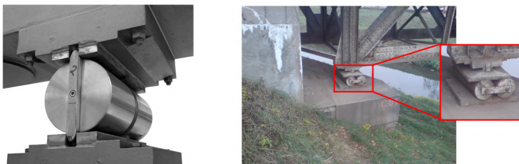
Obrázek 15: Mostová ložiska ([7] a [8])
