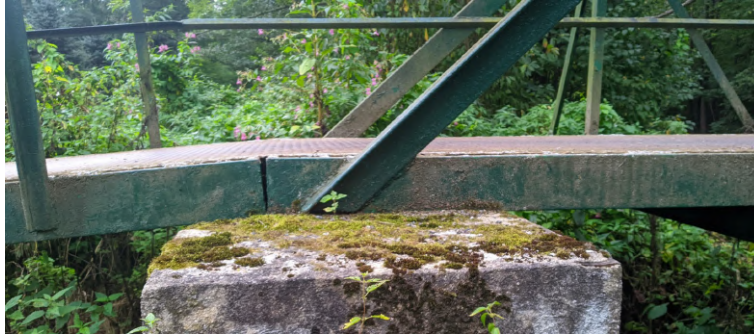
Obrázek 16: Vazba prutové soustavy se základovým tělesem
