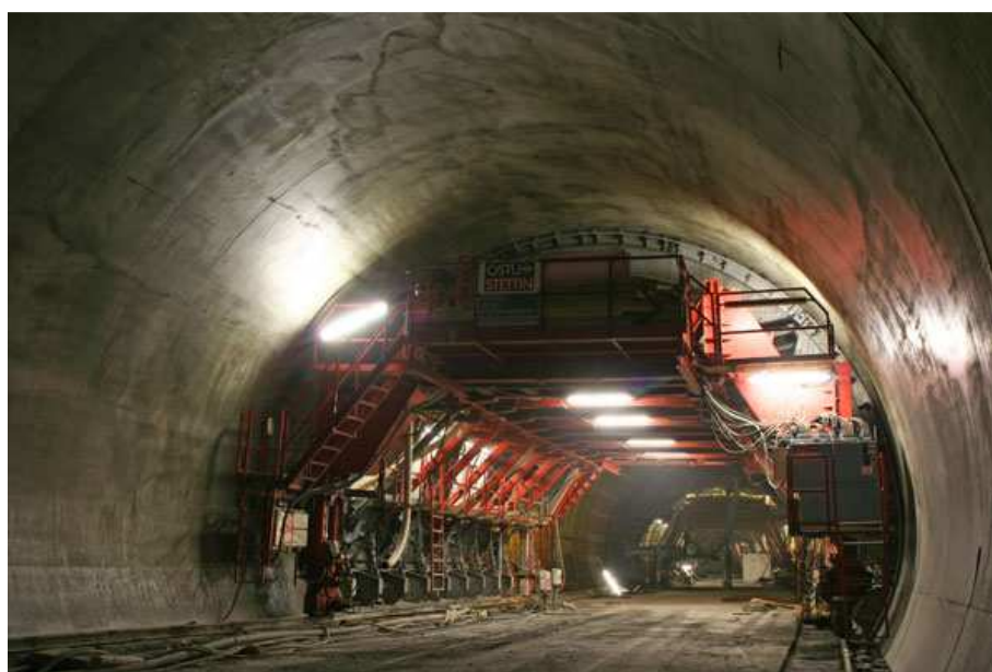
Obr. Bednění horní klenby
