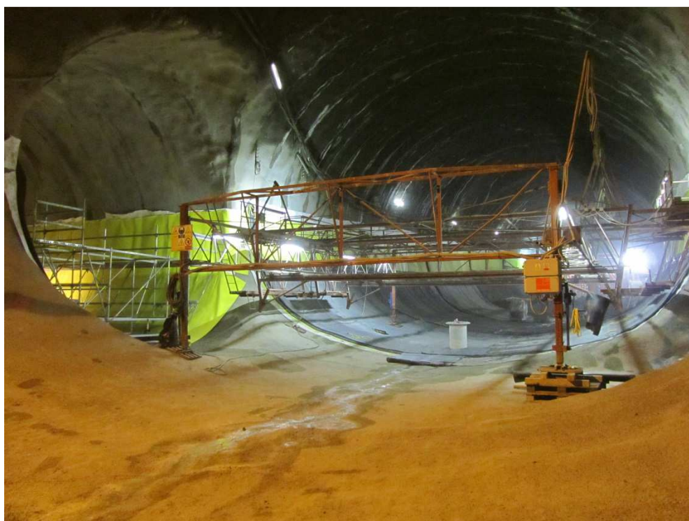
Obr. Fotografie propojení tunelové trouby se vzduchotechnickým kanálem
