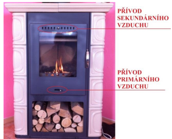
Obr. 19 - Příklad spalovacího vzduchu
