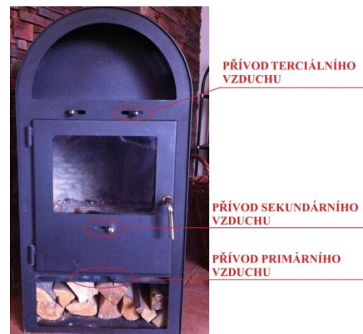
Obr. 21 - Příklad spalovacího vzduchu
