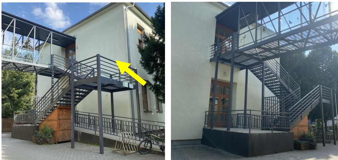
Obr. 29 - Fotodokumentace mostu ústící do budovy 6F, pohled ze západní strany (vlevo), pohled z východní strany (vpravo)
