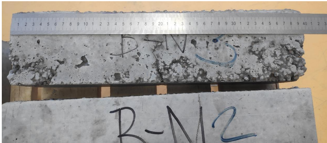
Obr. 43: Kaverny na zkušebním hranolu B-N3
