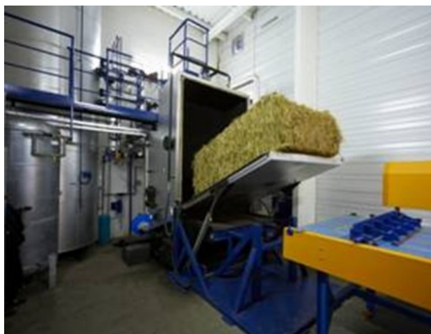
Obr. 2.14. Doprava balíku ke spalování do předkomory [7]
