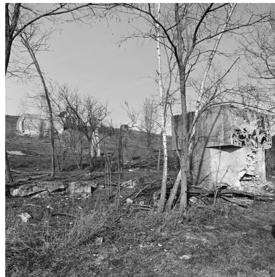
pozostatky zo zaniknutých kúpeľov - betónové rezervoáre vody
