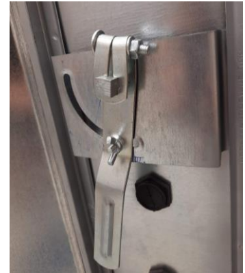
Obr. 12. 2: Pohled na jednotku po namontování přechodového potrubí a těsné regulační klapky.
