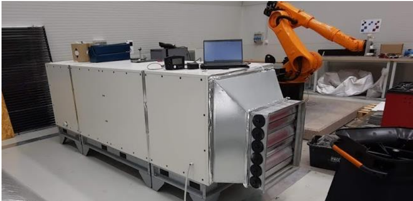
Obr. 12. 2: Pohled na jednotku po namontování přechodového potrubí a těsné regulační klapky.
