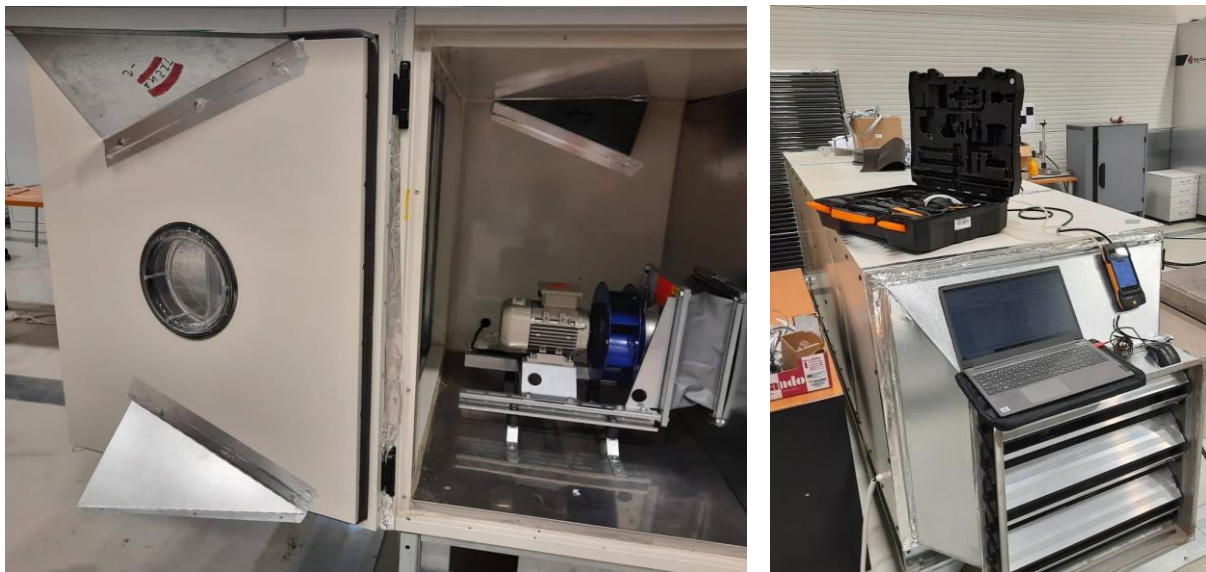
Obr. 5.12, 5.13: Pohled do ventilátorové komory po instalaci náběhových plechů s důkladným utěsněním a vyhlazením styku náběhového plechu a ventilátorové komory, pohled na měření.
