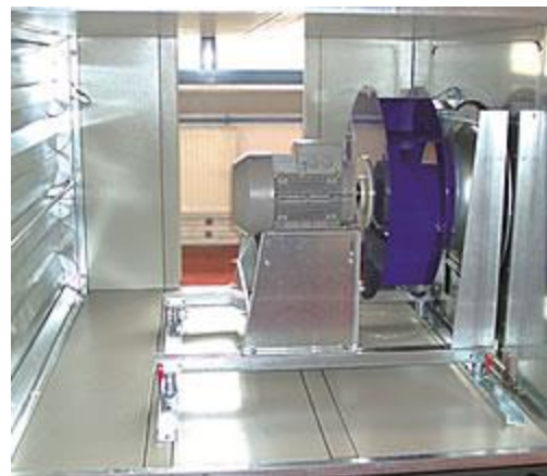
Obr. 1.1: Ventilátor s volným oběžným kolem instalovaný ve ventilátorové komoře [2].
