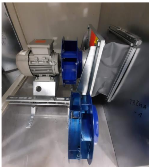
Obr. 12. 9, 10: Pohled ventilátorovou komoru a inovativní dvouřadé kolo.
