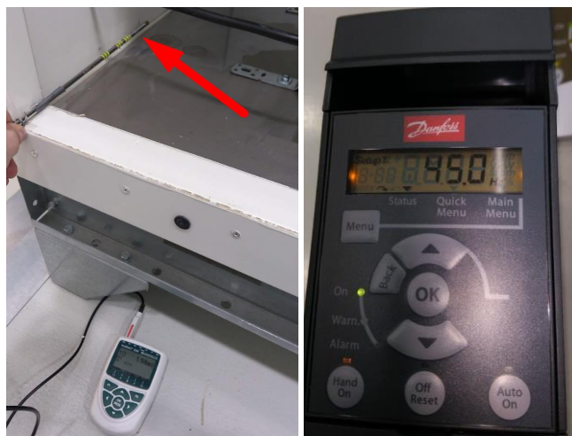
Obr. 12. 15, 16: Pohled na měření rychlostních poměrů a způsob regulace výkonu vent..
