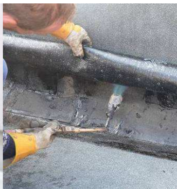
Obr. 7 – natavení hydroizolace
