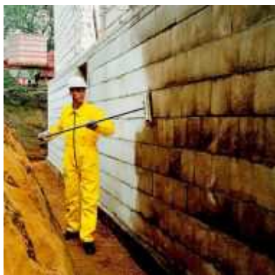
Obr. 5 – očištění podkladu
