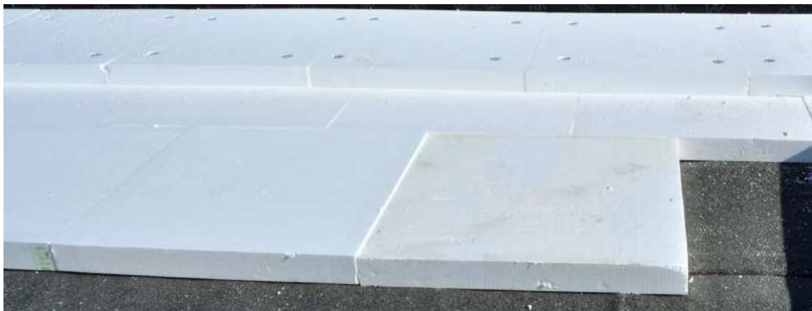
Obr. 46 - kotvení a převazba tepelného izolantu
