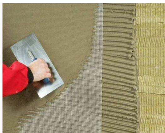
Obr. 42 - vložení perlínky na minerální vlákna
