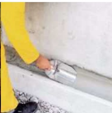
Obr. 6 – utvoření přechodového klínu
