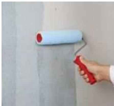
Obr. 25 - penetrace podkladu
