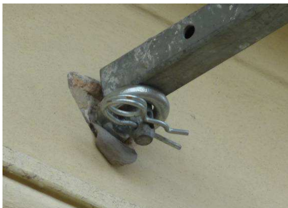
Obr. 12 - kotvení lešení do fasády
