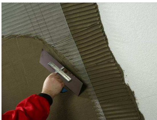
Obr. 41 - vložení perlínky na polystyrén
