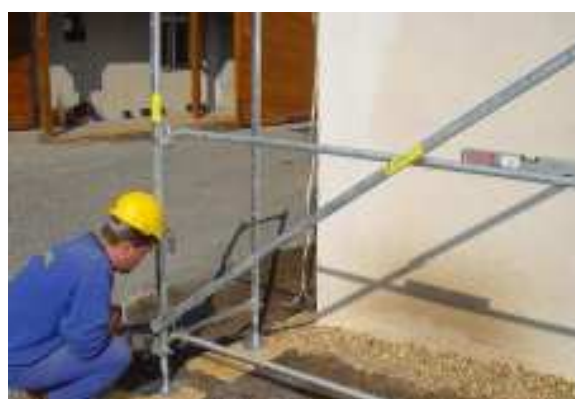
Obr. 10 - vyrovnání rámu pomocí vodováhy
