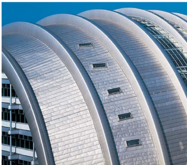
Obr. 25 Budova Ludwig-Erhard-Haus v Berlíně s typickým matným povrchem otryskaným drceným sklem [31]
