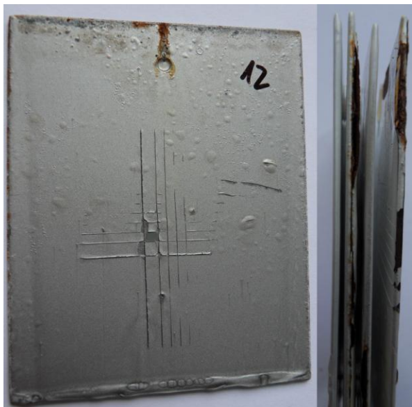
Obr. 38 Ukázka puchýřování vzorku č. 12 a odlupování povlaku 3. nátěrového systému na hranách
