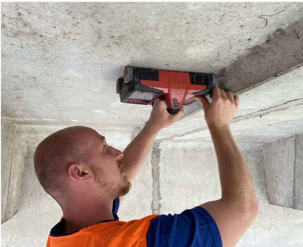
Obr. 3.34 Provádění liniového skenu
