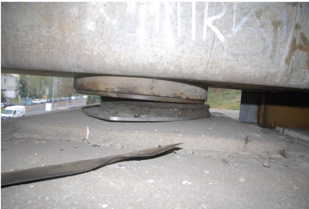
Obr. 3.24: Pravé ložisko na O1 [25]
