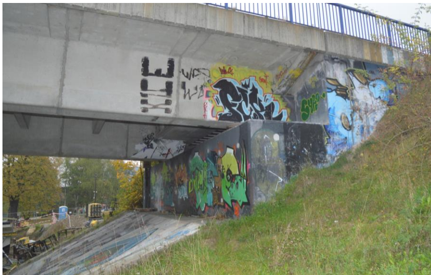
Obr. 3.8: Pohled na opěru O6 [25]
