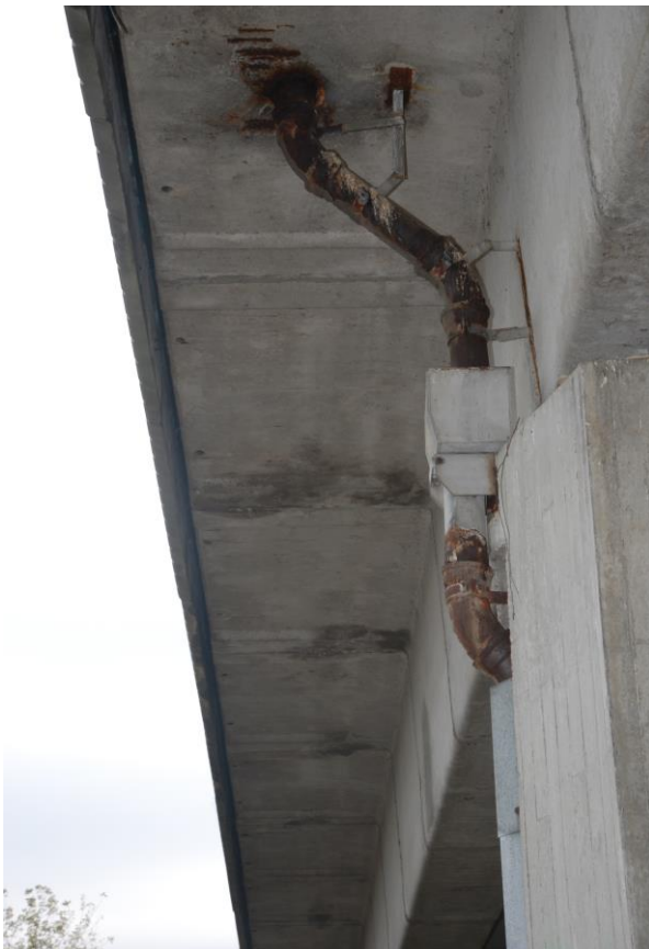
← Obr. 3.22: Levá konzola s odvodňovačem [25]
