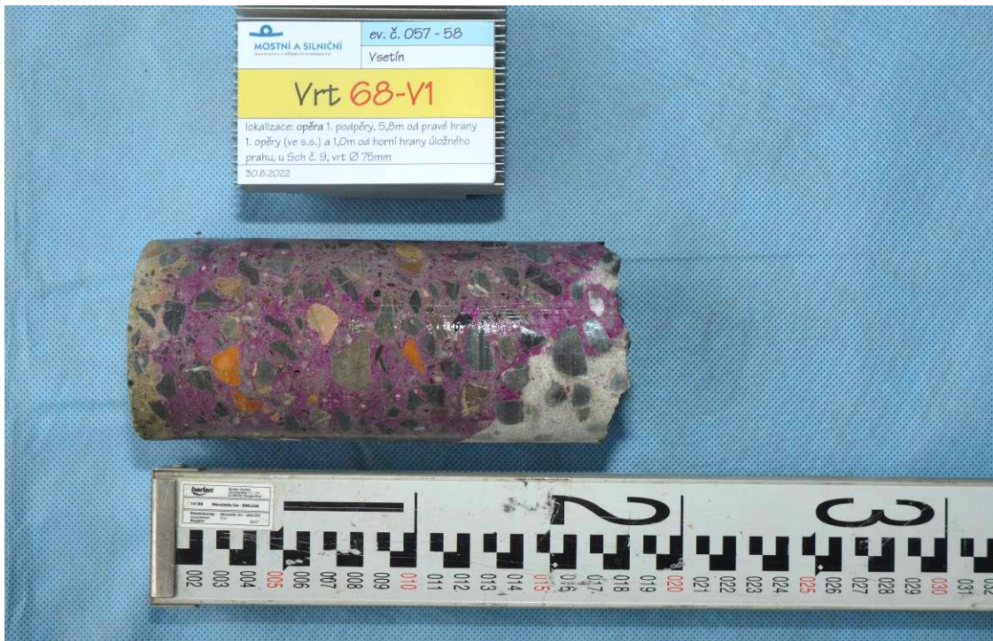
Obr. 3.56: Jádrový vývrt z 1. opěry [25]
