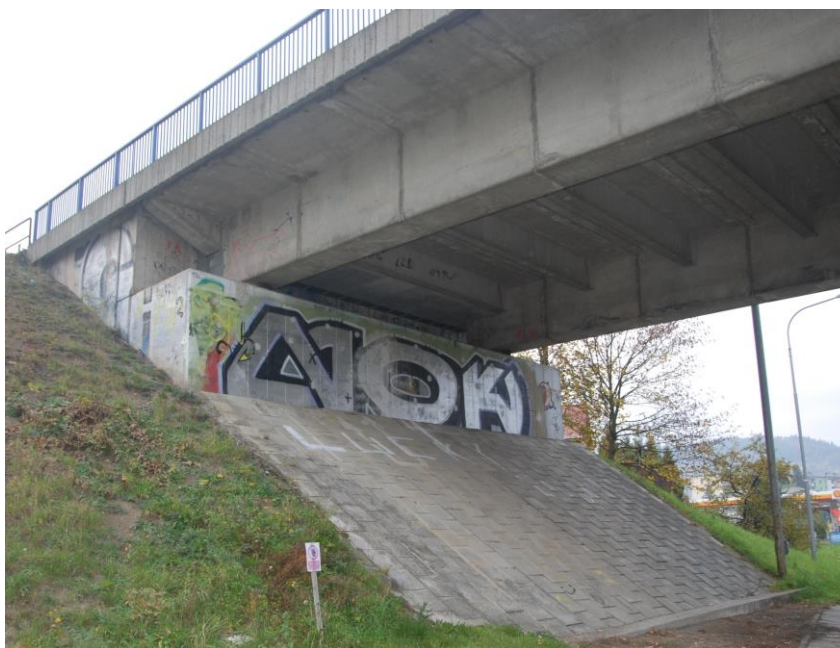
Obr. 3.7: Pohled na opěru O1 [25]
