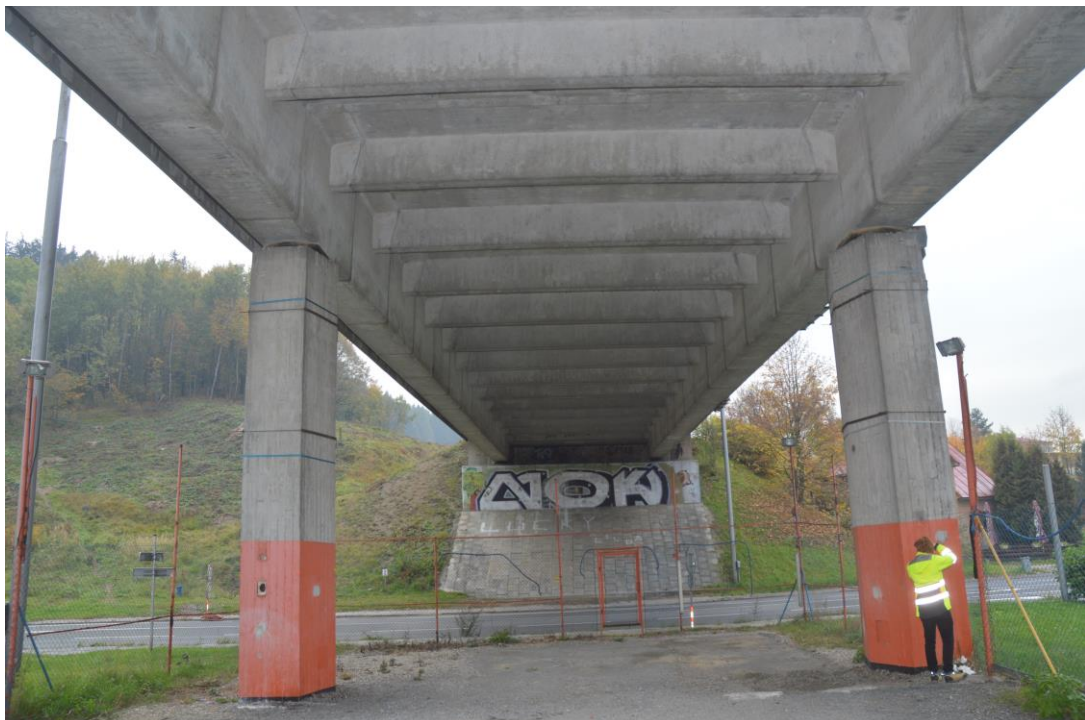
Obr. 3.6: Pohled na mezilehlé podpěry 2.1, 2.2 a 1. opěru O1 [25]
