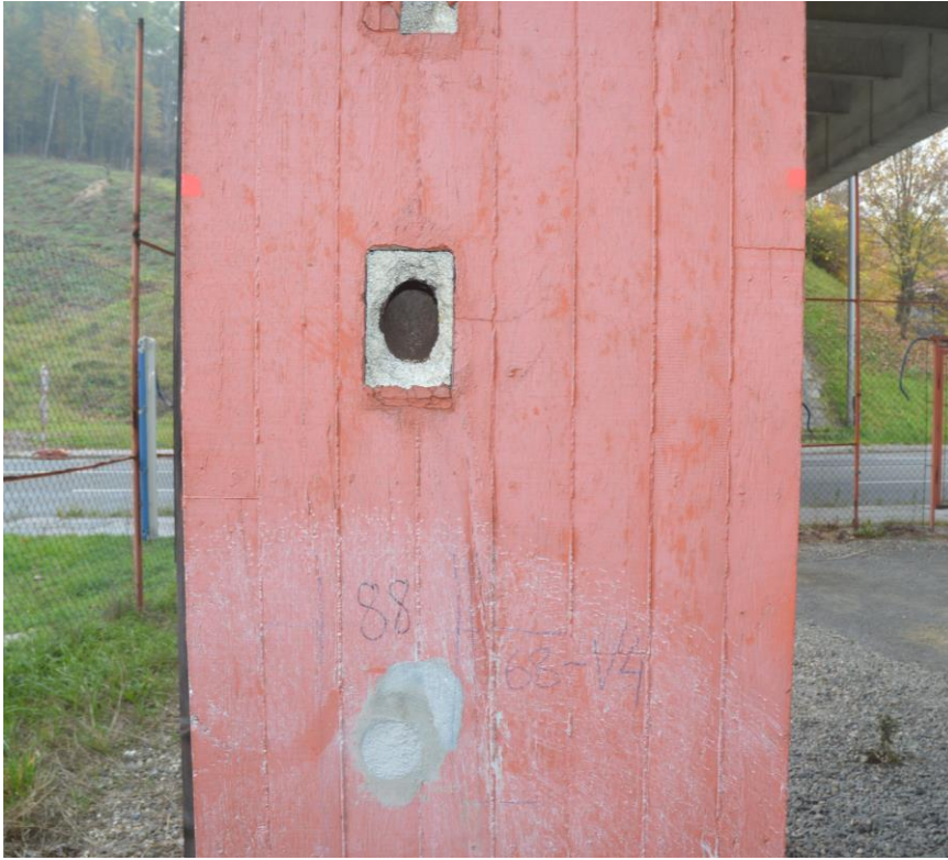
Obr. 3.14: Pohled na mezilehlou opěru – sloup P2.2 [25]
