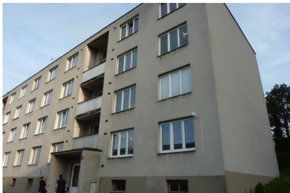
Foto č. 1 – Průčelí bytového domu SZ
