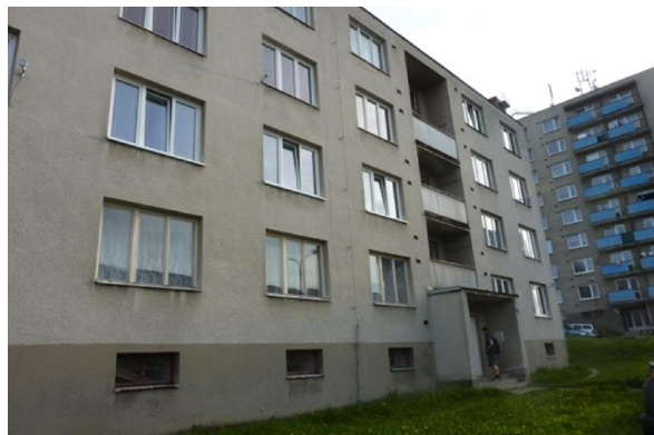
Foto č. 2 – Průčelí bytového domu SV
