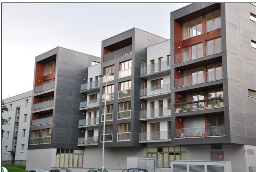
Obr. č. 9 – Realizace nekontaktního zateplení s obkladem z vláknocementových desek (28)
