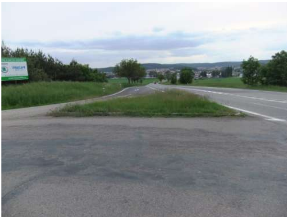
Jihozápadní pohled na současnou křižovatku silnic S I/23 a SII/394
