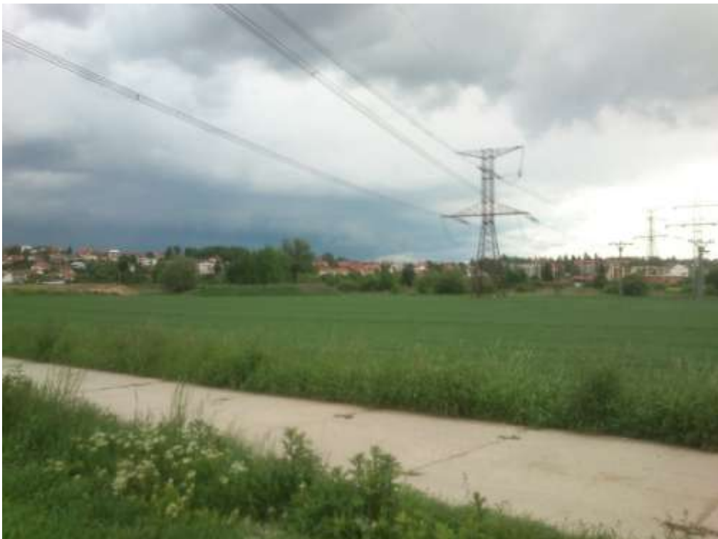
Přemostřovaná účelová komunikace km 1,261 81
