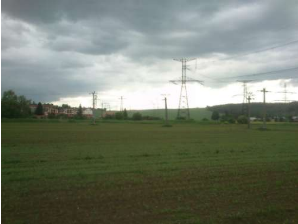
Severní pohled z účelové komunikace za železničním násypem
