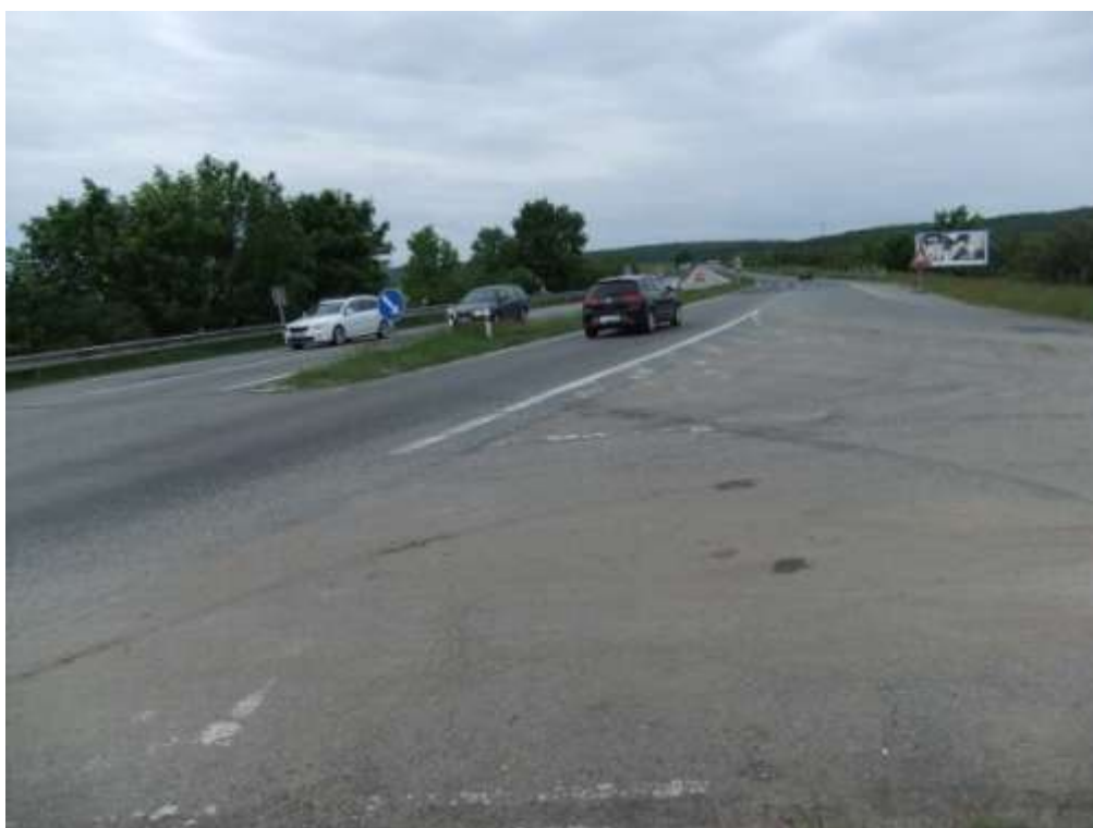
Pohled z křižovatky na 4 – pruhovou S I/23 vedoucí k Brnu
