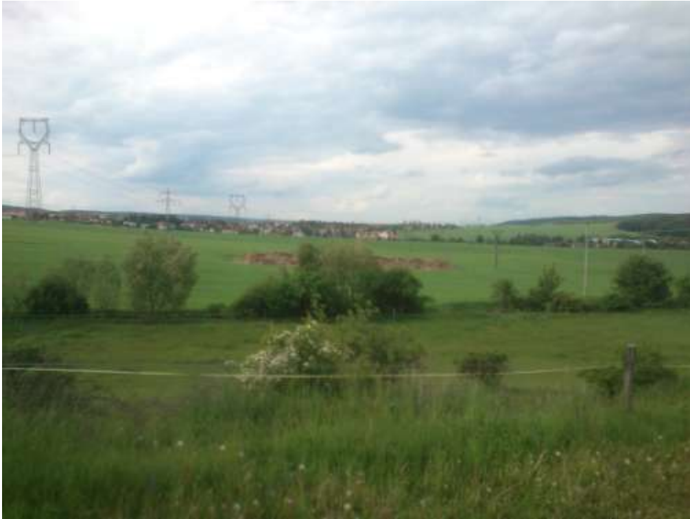
Násyp pod nímž bude zřízen propustek km 0,517 74, severní pohled
