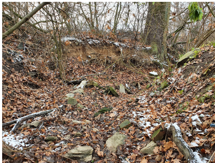
Obrázek 24 Pohled na vzdušní líc hráze s odtokovým korýtkem [Růžička 01/2022]
