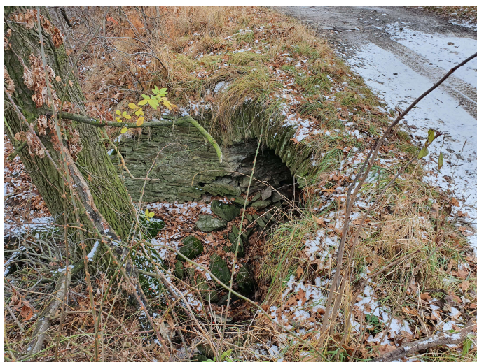
Obrázek 30 Pohled na propustku ze vzdušného líce hráze [Růžička 01/2022]
