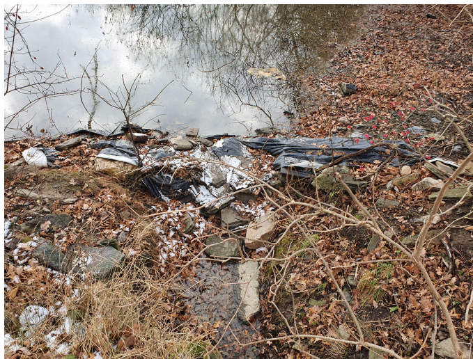
Obrázek 28 Pohled na kamennou konstrukci, sloužící jako přeliv [Růžička 01/2022]
