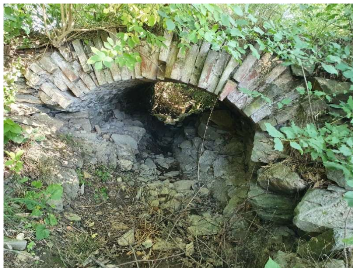
Obrázek 27 Pohled na propustek z návodní strany [Růžička 06/2022]
