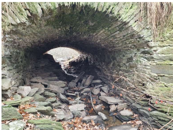
Obrázek 29 Pohled do propustku ze vzdušného líce hráze [Růžička 01/2022]
